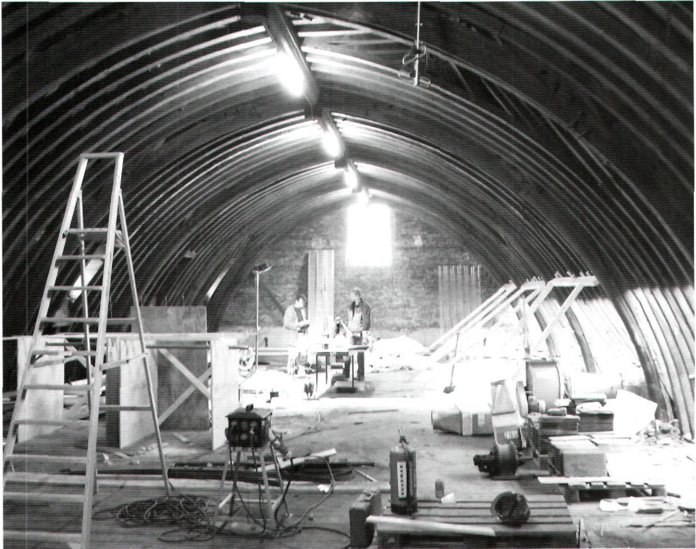
Afb. 11. Tongewelfconstructie op de voormalige kapel van de Witte Nonnen (Dominicanessen) in Leiden, thans Academiegebouw van de Universiteit Leiden herbouwd na brand in 1616 (foto auteur, 15.12.2006)
