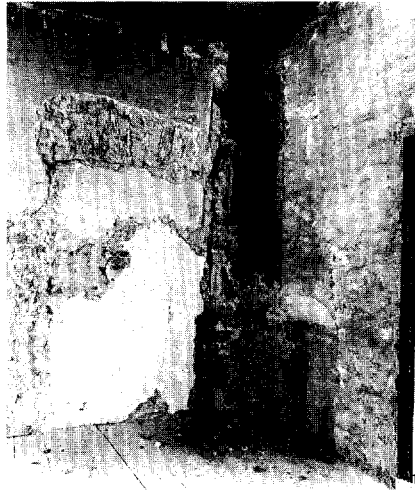
12. Dichtgemetselde doorgang in de achtergevel op de eerste verdieping boven de hal, foto A.J. van der Wal RDMZ Zeist.
