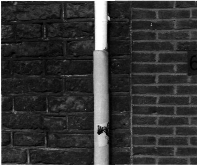
Afb. 1. Restauratief hersteld voegwerk aan de Plompstorengracht te Utrecht (deze en volgende foto's zijn door de auteur gemaakt in 2005)
