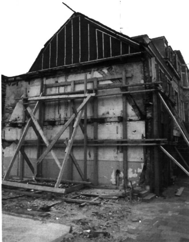
Afb. 9. Zijgevel van Gansstraat 8 Utrecht met daarin een kapspant van een lager huis (dia auteur 2002).
