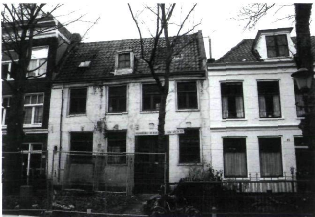
Afb. 12. Bellamystraat 80 Amsterdam (dia auteur 2000).
