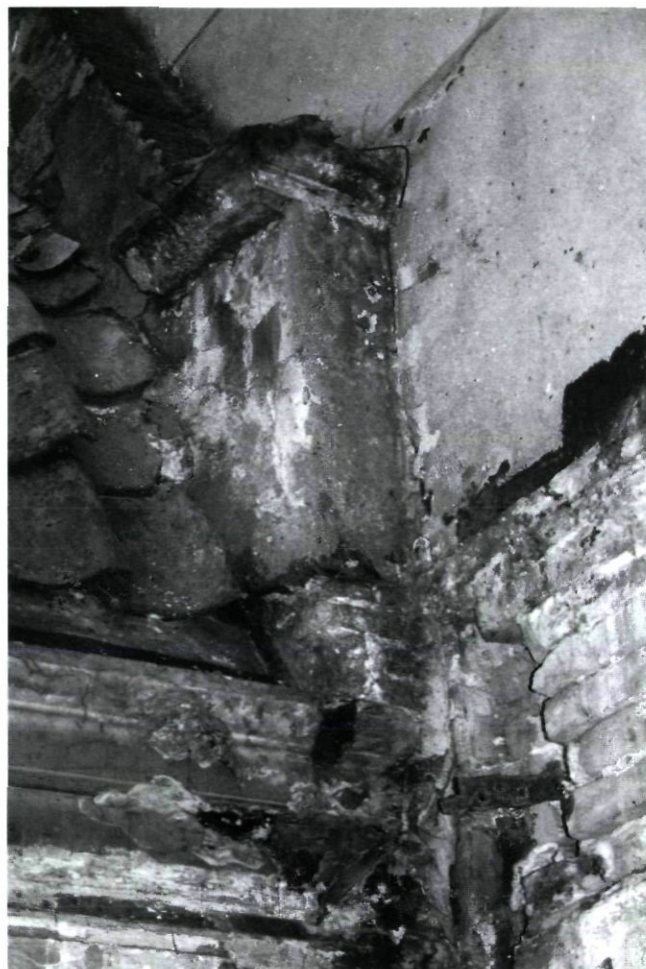
Afb. 16. Zandstenen dekplaat op de aanzet van de (zij)tuitgevel aan de achterzijde van Bellamystraat 80 Amsterdam (dia auteur 2000).
