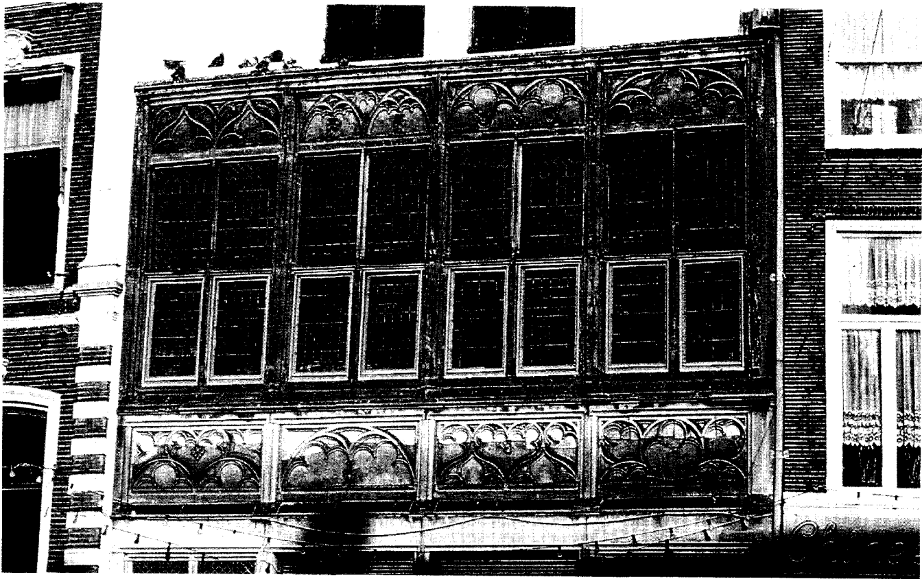
Afb. 15. Zwolle, Melkmarkt 10, natuurstenen fragment op de verdieping naar verwachting uit dezelfde tijd als de kap: 1474 (foto auteur 1975).
