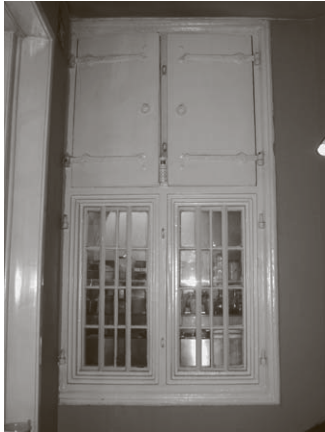
Afb. 2. Ingebouwd houten kruisvenster, XVII B, in Doelensteeg 8 Leiden
