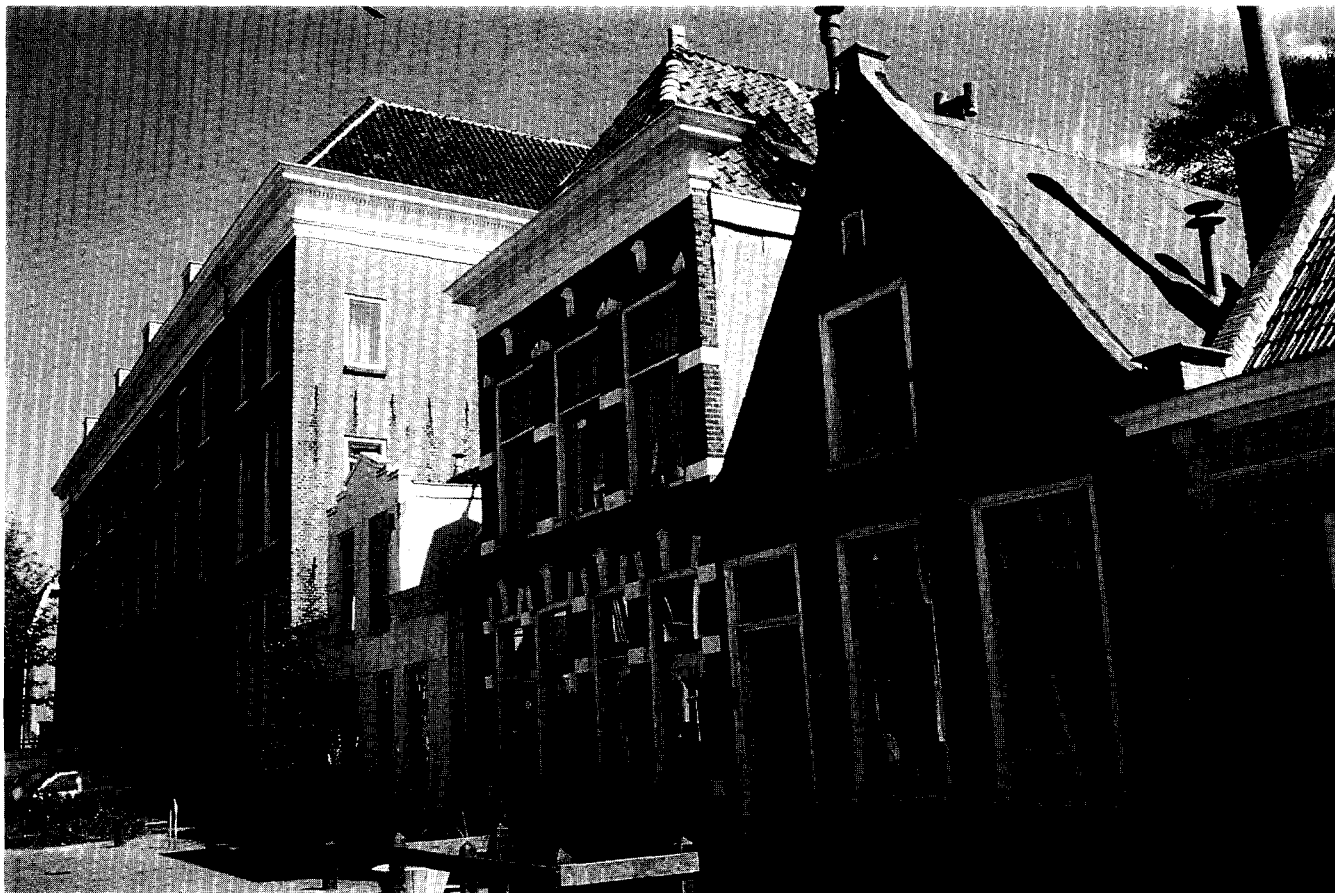
9. Groningen, bedreigde straatwand aan de Kleine Leliestraat (foto auteur)
