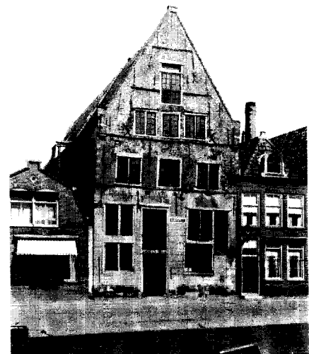
Afb. 8. Hoorn, Korenmarkt 8 uit 1548: A. sleutelstuk op de b.g., foto RDMZ 1992; B. voorgevel voor de restauratie, situatie 1949, foto G.Th. Delemarre RDMZ.
