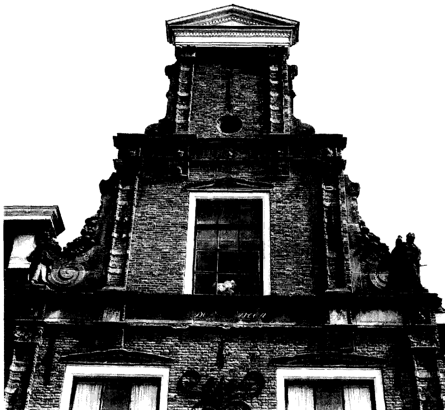
Afb. 1. Geveltop van Mient 31 Alkmaar, gebouwd in of direct na 1546, foto RDMZ 1992.
