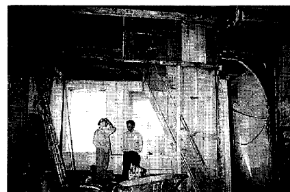
Afb. 5. Interieur uit 1518 van Spui 2 te Edam tijdens de restauratie in 1991, foto auteur 1991.
