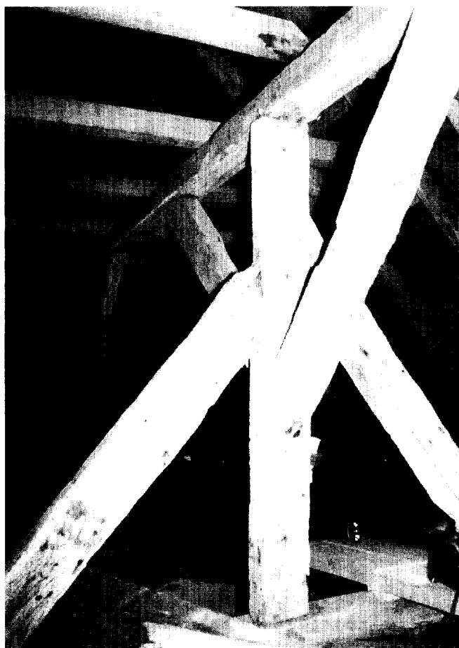
Afb. 8. Swichum, hanebalkfliering in de kap van de kerk. Voor de schoren zijn oude sporen uit 1234 \pm 6 jaar hergebruikt (foto auteur 1997).
