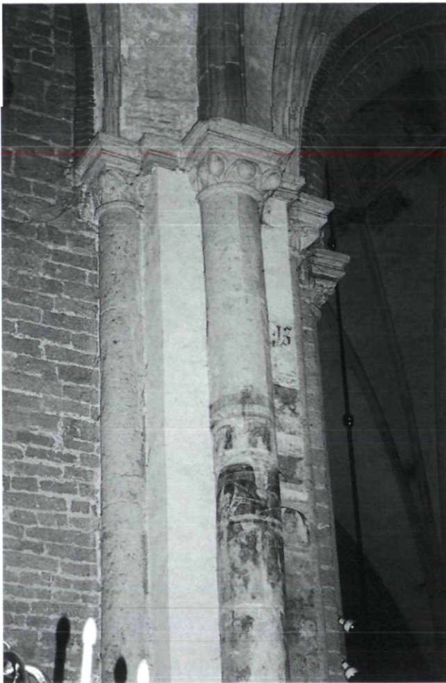
Afb. 15. Deventer, Lebuinuskerk, zuidelijke vieringspijler bij koor met IHS (foto auteur 2003)
