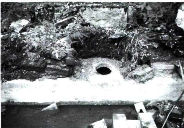
Afb. 17. Gewapend betonnen beerput aan de buitenzijde van kasteel De Haar. Foto auteur
