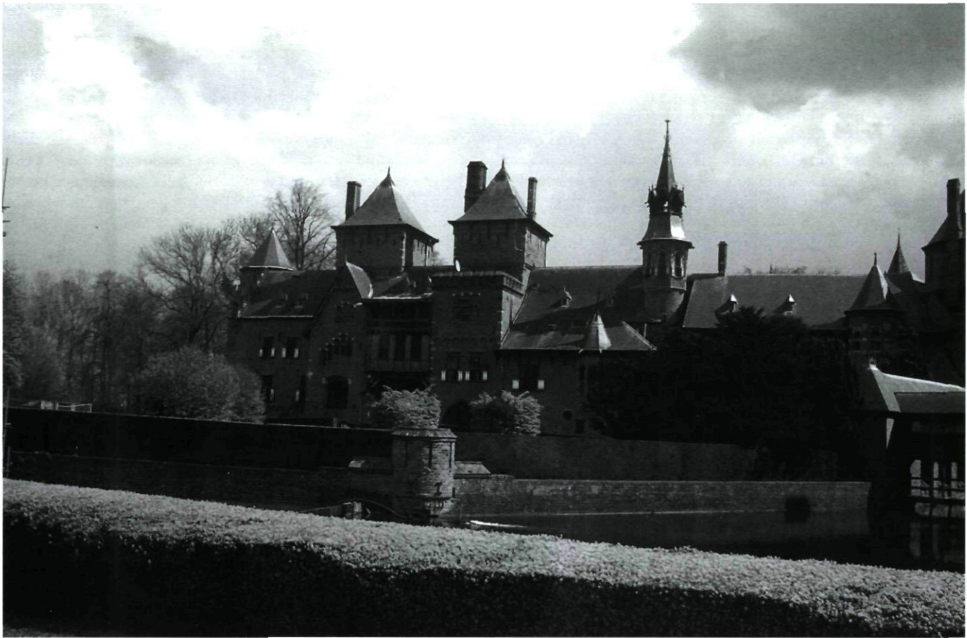
Afb. 12. Het châtelet van kasteel De Haar waarin de verwarmingsketels, een werkplaats en slaapvertrekken voor de beide dochter van de Baron zijn ondergebracht. . Via een houten loopbrug met twee verdiepingen kan men van het châtelet over de gracht het kasteel betreden. Foto auteur
