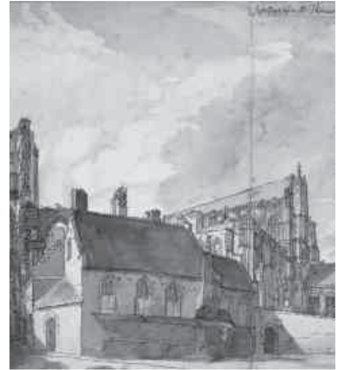
Afb. 3. Heilig-Kruiskapel (voorgond) en Dom vanuit het zuidwesten. Rechts achter de kapel de drie gespaard gebleven schipkapellen met daarachter het transept van de Dom. Boven de kapel steken de aanzetten van de luchtboogstoelen uit. Geheel links is de doorgang tussen Domkerk en toren, bedongen door het kapittel van Oudmunster. Tekening door Jan de Beyer, 1745 ( Den Haag, Koninklijke verzamelingen, MCS/178 )
