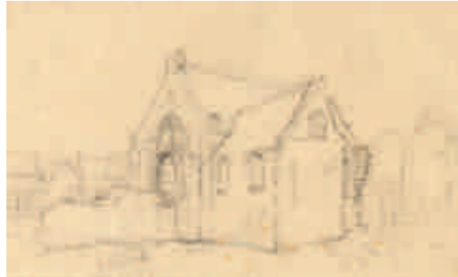
Afb. 9. De Heilig-Kruiskapel vanuit het noordoosten tijdens de afbraak. Het koor (links) is al gesloopt. Het schuin naar voren stekende bouwdeel is de noordelijke dwarsarm. Schets van Cornelis van Hardenbergh, 1826 (Het Utrechts Archief, collectie beeldmateriaal, 37547)
