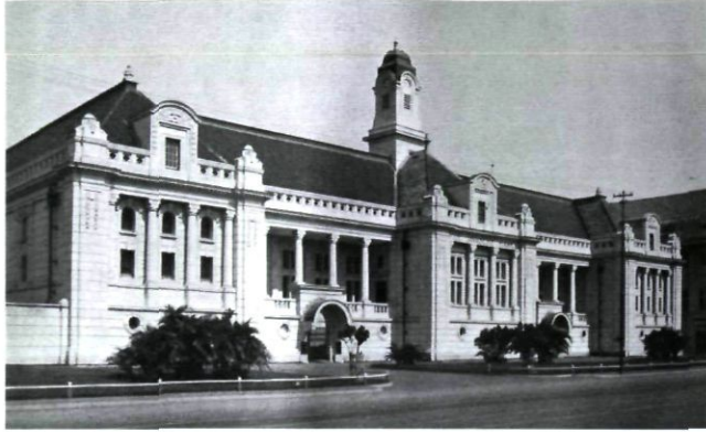
Afb. 6. Batavia, Hoofdkantoor Javasche Bank, Hulswit, Fermont en Cuijpers 1909 (De Bree, Javasche Bank 1828 – 1928 )
