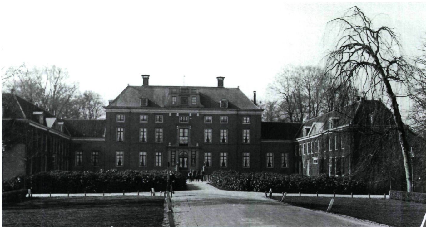
Afb. 12. Het Slot van Zeist omstreeks 1920. Alle vensters van het middengebouw hebben een empire-verdeling. Het gietijzeren portiek dat in 1913 nog beschreven wordt in het tijdschrift Buiten , is inmiddels afgebroken (foto RDMZ, z.j.).
