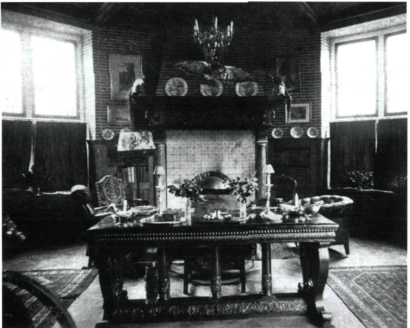
Afb. 32. De zitkamer in de voorste toren in 1932. Repro uit Het Bouwbedrijf, 9de jrg. no. 18 (26 augustus 1932), pagina 228.
