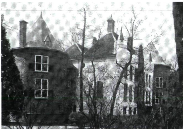
Afb. 33. De voor- en linkerzijgevel in 1932. De beide torens zijn gebouwd, de gevels zijn nog gepleisterd. Repro uit Het Bouwbedrijf, 9de jrg. no. 18 (26 augustus 1932), pagina 228.
