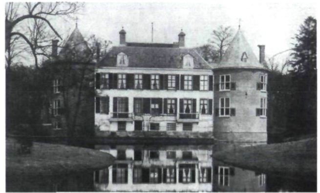
Afb. 34. De achtergevel in 1932. Repro uit Het Bouwbedrijf, 9de jrg. no. 18 (26 augustus 1932), pagina 227.
