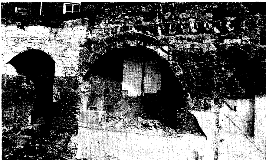
Afb. 4. Maastricht, vrijgelegd gedeelte (stadszijde) van de 13e eeuwse ommuring van de stad ten noorden van het Vrijthof. Uit bouwhistorisch onderzoek bleek dat zich hierin het restant bevond van een nog onbekende muurtoren uit de bouwtijd van de muur (foto auteur).
