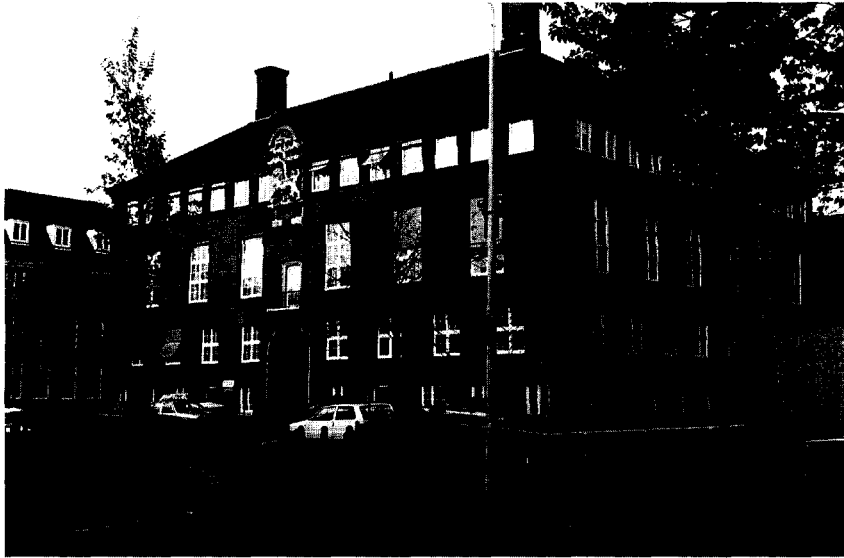
Afb. 2. Het voormalige Ministerie van Onderwijs, Kunsten en Wetenschappen in Den Haag (1950-1953) van G. Friedhoff en M. Bolten: bij het per perse gaan van dit artikel was men net begonnen met de sloop. Herkomst: RGD
