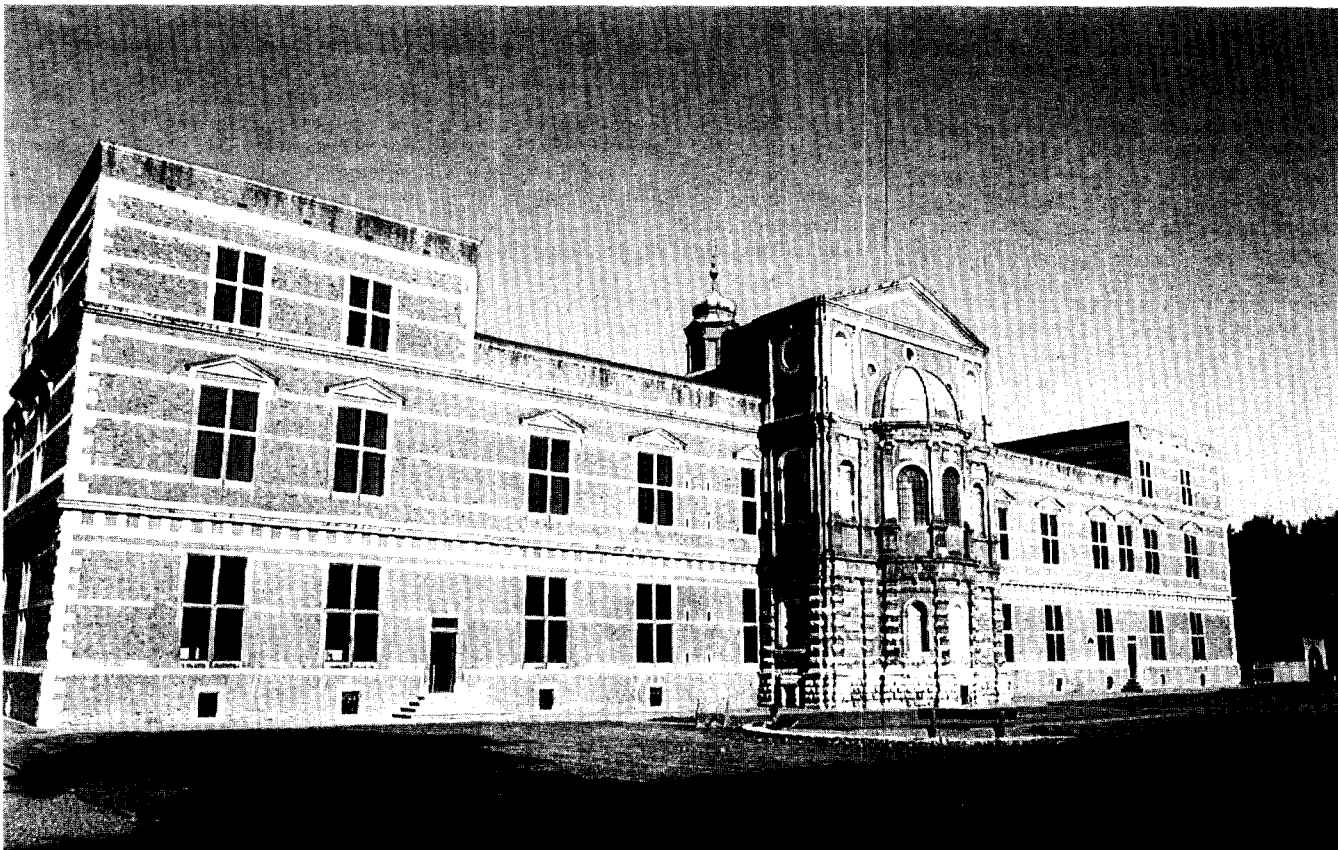
Afb. 6. Oostgevel van het kasteel te Jülich met daarin opgenomen de koorsluiting van de kapel (foto auteur).
