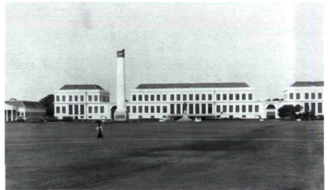
Afb. 2. Voorzijde van het Gouvernements Hôtel met de monumenten van Waterloo en Coen (ca. 1895). Het gebouw heeft een driedelige opzet, een lage begane grond met daarboven twee hoge bouwlagen en een relatief laag dak (KITLV, inv.no. 2726)
