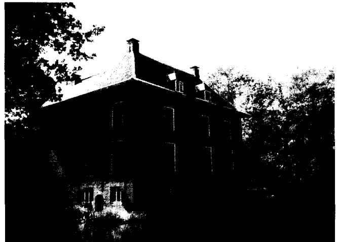
Afb. 5. Huis te Linschoten. Zij- en achtergevel. Foto C. van Schaik 1998.
