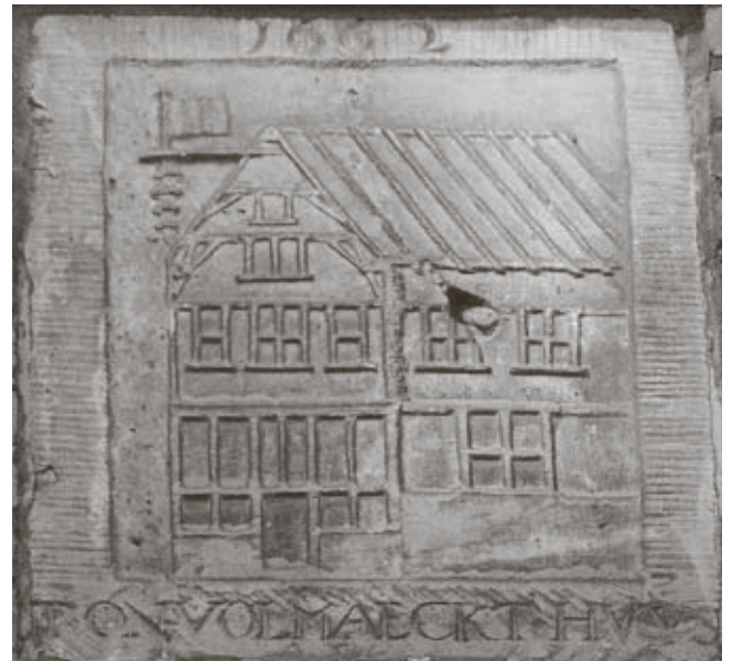
Afb. 3. Door scheiding van gilden en conflicten tussen aannemers konden aanzienlijke vertragingen ontstaan. Gevelsteen t onvolmaeckt hvvs, uit 1662, Madelievenstraat 8, Amsterdam (foto Pancras van der Vlist, overgenomen uit: O.W. Boers, De gevelstenen van Amsterdam , 2e dr., Hilversum 2007, p. 164).
