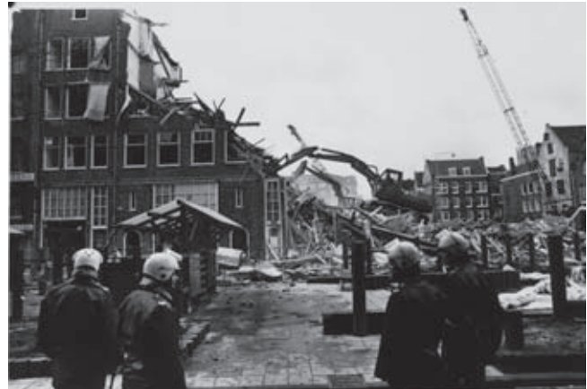
Afb. 2. Sloop van historische bebouwing aan de Recht Boomssloot in de Amsterdamse Nieuwmarktbuurt in 1975 (Stadsarchief Amsterdam)
