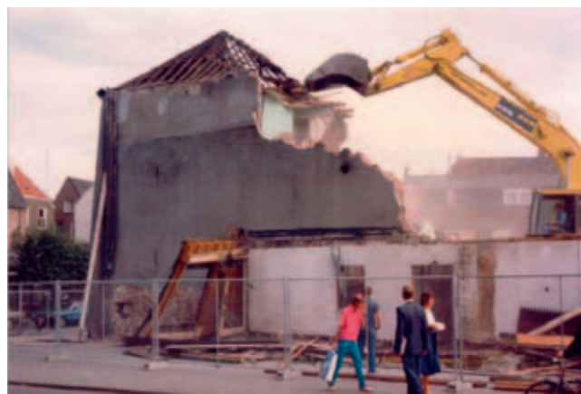
Afb. 5. 's-Hertogenbosch, sloop van een middeleeuws pand in de Lepelstraat in 1986 (na bouwhistorische documentatie) ten behoeve van nieuwbouw bankgebouw ABN/AMRO (Afdeling Bouwhistorie, Archeologie en Monumenten, gemeente 's-Hertogenbosch)
