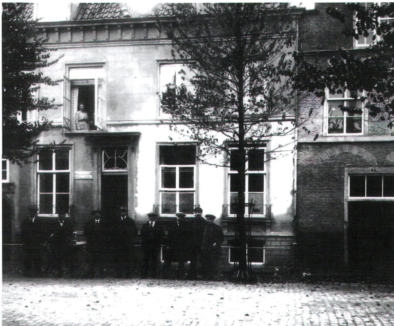
Afb. 8. Het Centraal Telefoonbureau van de firma Ribbink van Bork & Co, sinds 1899 Algemeene Telefoon Maatschappij (A.T.M.), was ondergebracht op de verdieping van het pand Papengracht 23, 1905-1923. De foto van het gebouw en het mannelijk personeel dateert uit 1918. (Uit: Steensma 1918 (zie noot 1), afb. [15])
