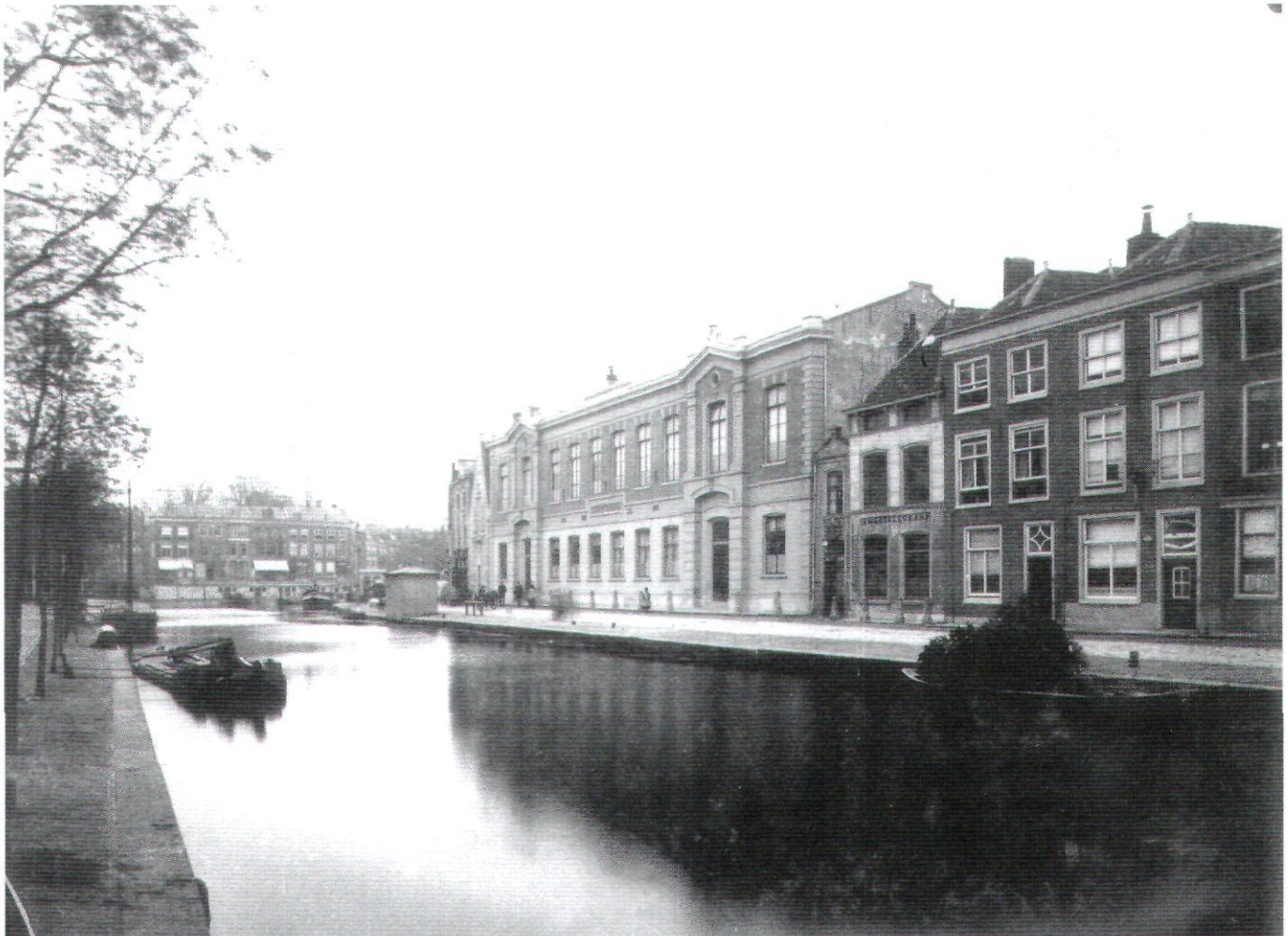
Afb. 3. De Aalmarkischool, nu met twee bouwlagen; de eerste verdieping werd toegevoegd in 1872 naar ontwerp van de nieuwe stadsbouwmeester Schaap; bij die gelegenheid werd de gevelindeling gewijzigd. Rechts ervan staat het telegraafgebouw. Toestand 1872-1889 (fotocollectie RAL PV3309.16a)
