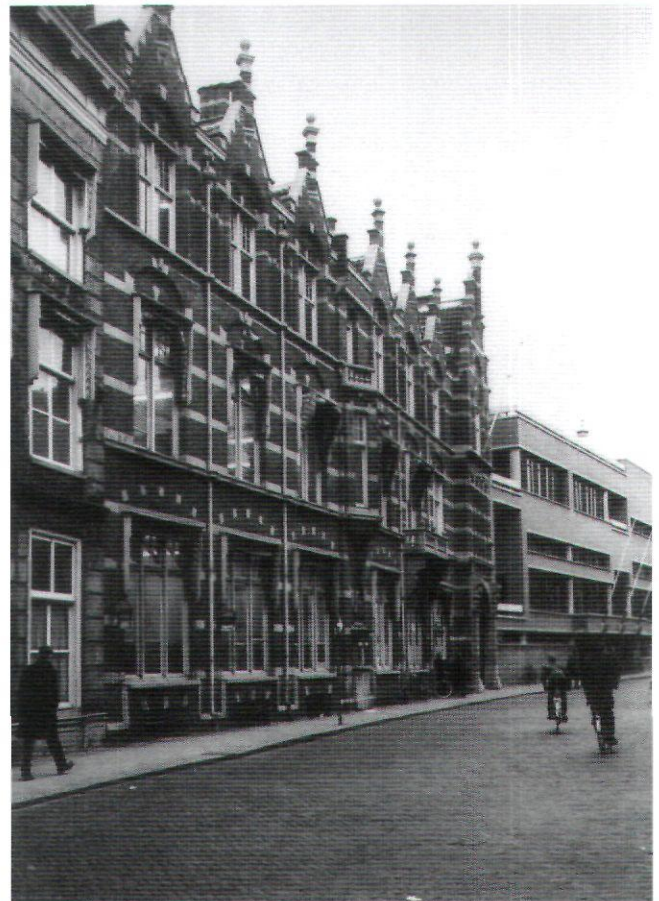
Afb. 11. De voorgevel van het postgebouw aan de Breestraat na de verbouwing van 1918-1921. Toestand 1921-1976 (fotocollectie RAL PV12010)
