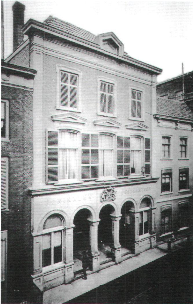
Afb. 1. Het postgebouw aan de Breestraat. Toestand 1872-1895 (fotocollectie Regionaal Archief Leiden (RAL) PV12002)
