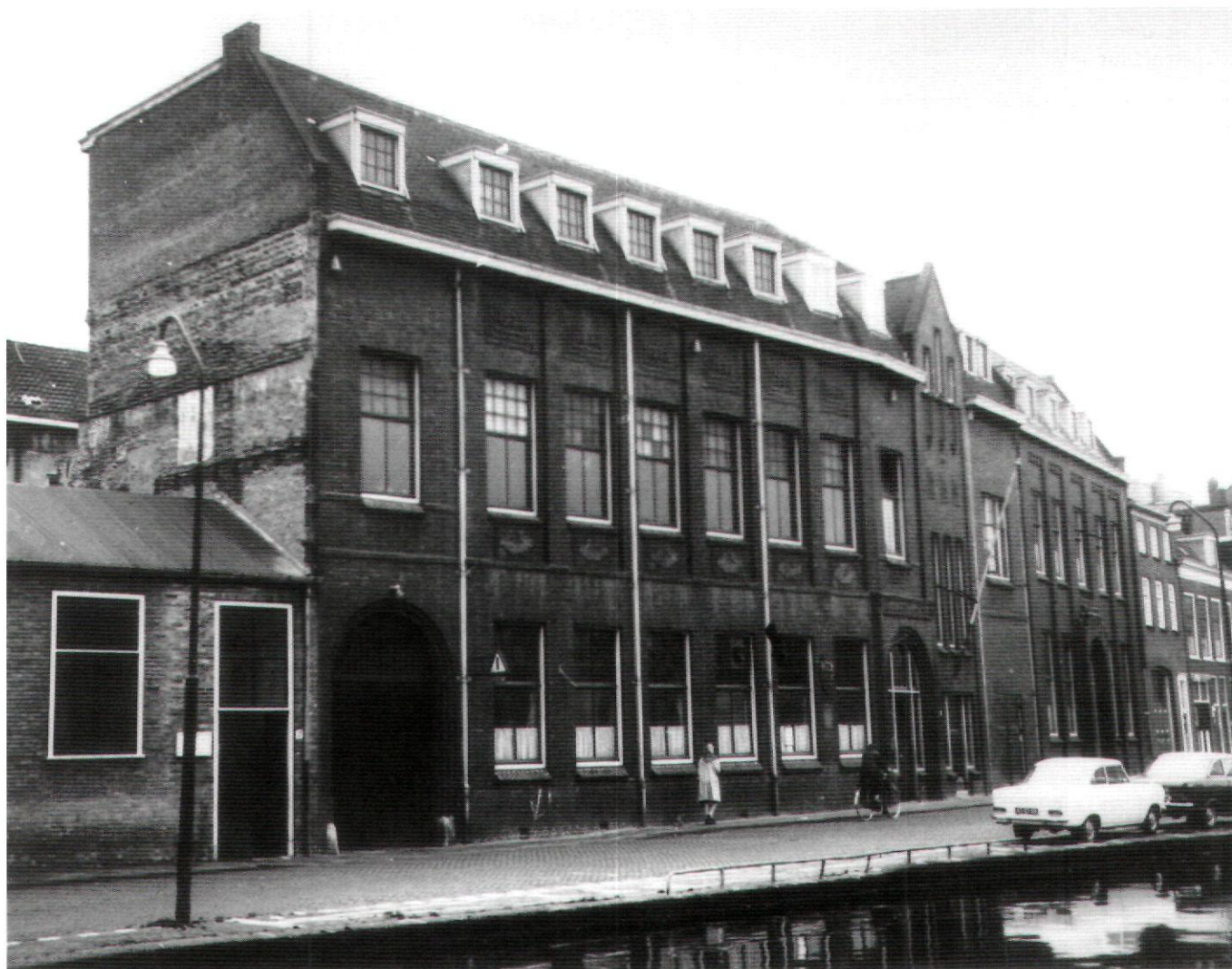
Afb. 10. De voorgevel van het nieuwe telegraaf- en telefoongebouw aan de Bloemmarkt. Toestand 1921-1976 (fotocollectie RAL PV12014)
