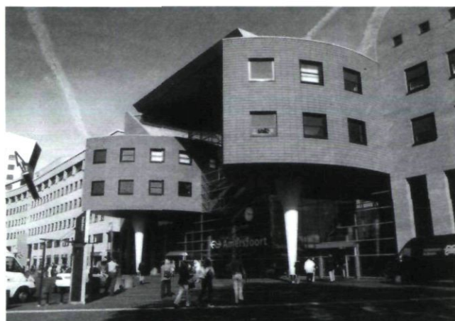
Afb. 5. Station Amersfoort uit 1997 (op de plaats van het oude uit 1902) van de architect J.A. van Belkum. Parodie van de architectuurmodes van de jaren negentig? (foto van de hand van de auteur)
