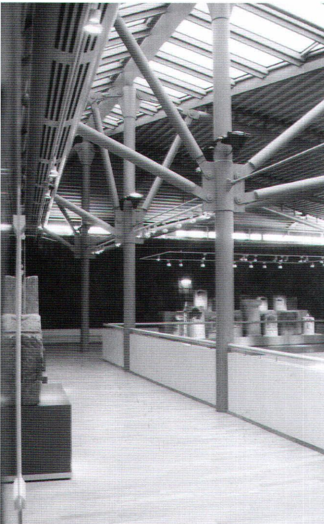
Afb. 4 Blik vanaf de tussenverdieping op de overkapping in glas en staal en de schragende stalen 'parasols' over de kleine binnenplaats van het R.v.O. (foto auteur)
