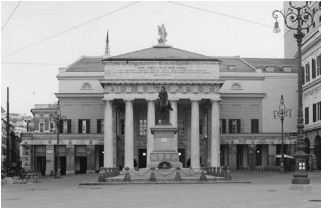
Afb. 15. Genua, Teatro Carlo Felice. Voorgevel (foto auteur, 2005)
