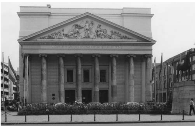
Afb. 14. Aken, Stadttheater. Voorgevel (foto auteur, 1985)
