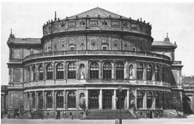
Afb. 16. Dresden, Erstes Hoftheater. Voorgevel. (Foto uit 1865, ETH Zürich)
