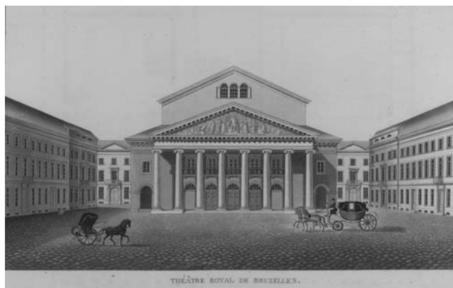
Afb. 6. Brussel, Muntchouwburg. Voorgevel (prent uit: P.J. Goetghebuer, Verzameling der merkwaardigste gebouwen in het Koninkrijk der Nederlanden , 1825)
