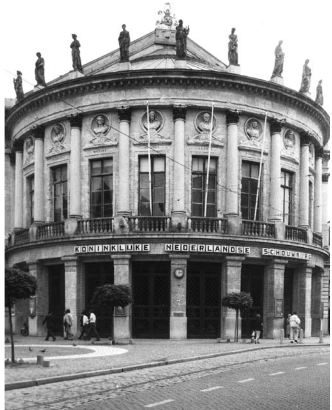
Afb. 17. Antwerpen, Koninklijke Schouwburg. Voorgevel (foto auteur, 1985)
