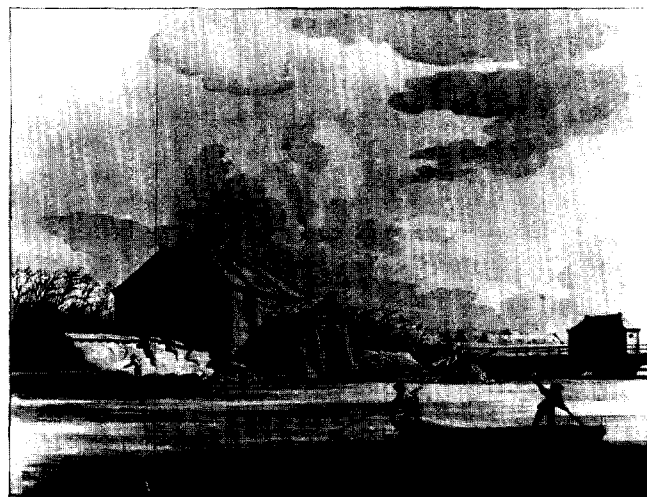
Afb. 5. Amsterdam, Muiderpoort. De 1e poort (1663) ingestort. Tekening in pen en penseel van Hendrik Henn, 1769.
