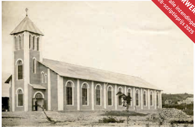
△ De kerk van Janwé op Curaçao, gebouwd in 1924 met technische steun van Isla-ingenieurs, is uitgevoerd in gewapend beton met stalen spanten en geldt als een vroeg voorbeeld van door industrialisatie beïnvloede Caribische kerkarchitectuur (Stadsarchief Tilburg, fotoarchief van de Fraters van Tilburg)
