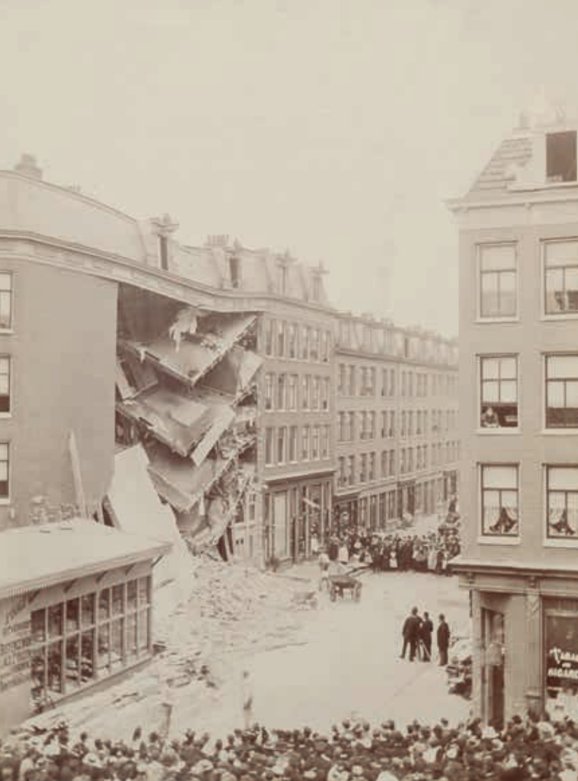
△ Ingestorte panden in de Pieter Nieuwlandstraat in Amsterdam, 1899 (Stadsarchief Amsterdam, foto: A. Kok)
