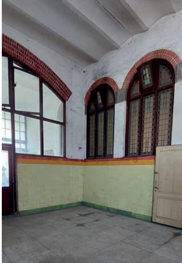
12. Interieur met tegellambrisering in Berlagekleuren en draaibare stalen inpendige ramen. De glas-in-loodramen zijn aangebracht in 1922 (foto Joost Dankers, 2023)
