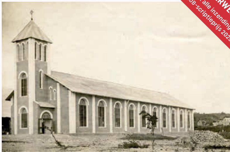
△ De kerk van Janwé op Curaçao, gebouwd in 1924 met technische steun van Isla-ingenieurs, is uitgevoerd in gewapend beton met stalen spanten en geldt als een vroeg voorbeeld van door industrialisatie beïnvloede Caribische kerkarchitectuur (Stadsarchief Tilburg, fotoarchief van de Fraters van Tilburg)
