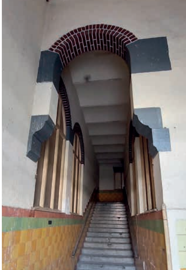
13. Trappenhuis met tegellambrisering (foto Joost Dankers, 2023)
