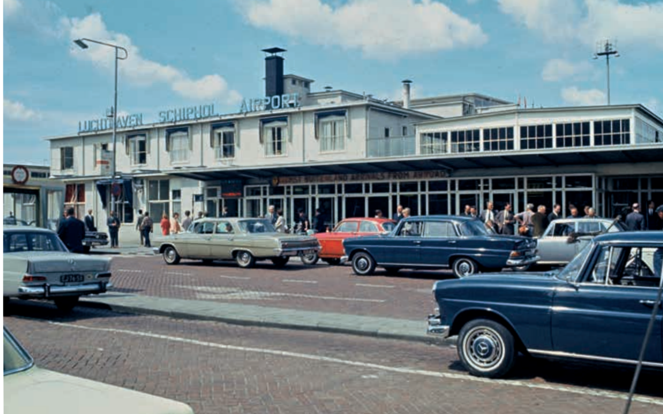
15. Het semipermanente stationsgebouw gezien vanaf de landzijde, jaren 1950 (SAA, 30470 Archief van Luchthaven Schiphol)
