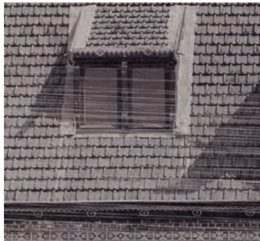
16. Kleine dakkapel en daklijst met daaronder sierstenen en tegelfries. De witte strepen door het beeld zijn telefoondraden. Detail van 9 (Nieuwe Instituut, Rotterdam)
