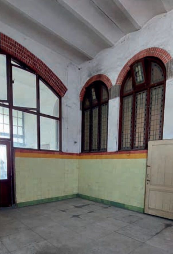
12. Interieur met tegellambrisering in Berlagekleuren en draaibare stalen inpendige ramen. De glas-in-loodramen zijn aangebracht in 1922 (foto Joost Dankers, 2023)
