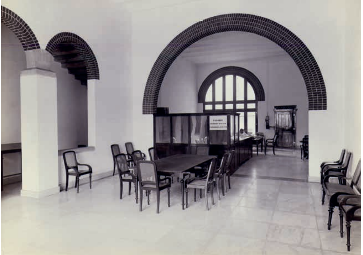
10. Interieurfoto kantoorgebouw de Algemeene Surabaya, 1902. Fotoatelier O. Kurkdjian (Historische collectie Nationale-Nederlanden, Arnhem)
