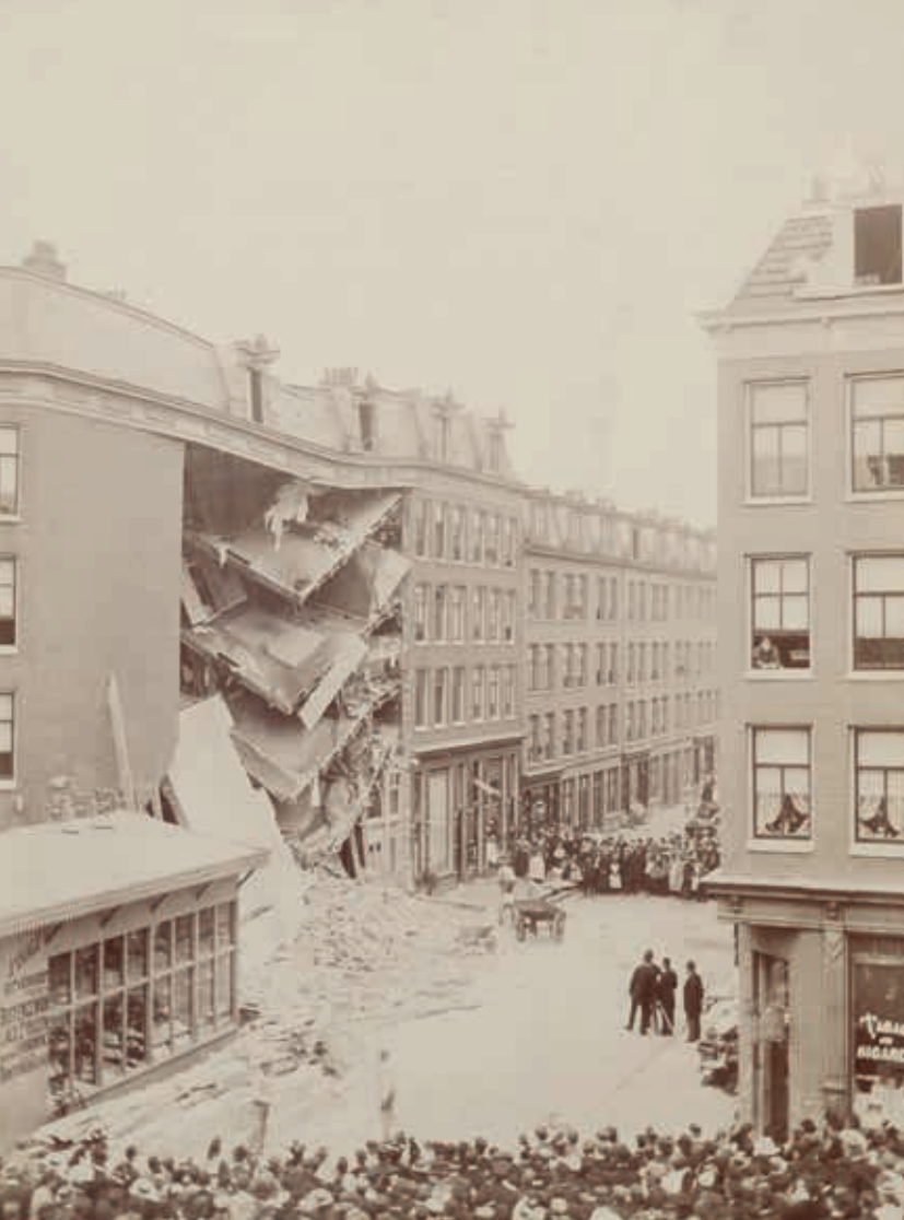
△ Ingestorte panden in de Pieter Nieuwlandstraat in Amsterdam, 1899 (Stadsarchief Amsterdam, foto: A. Kok)
