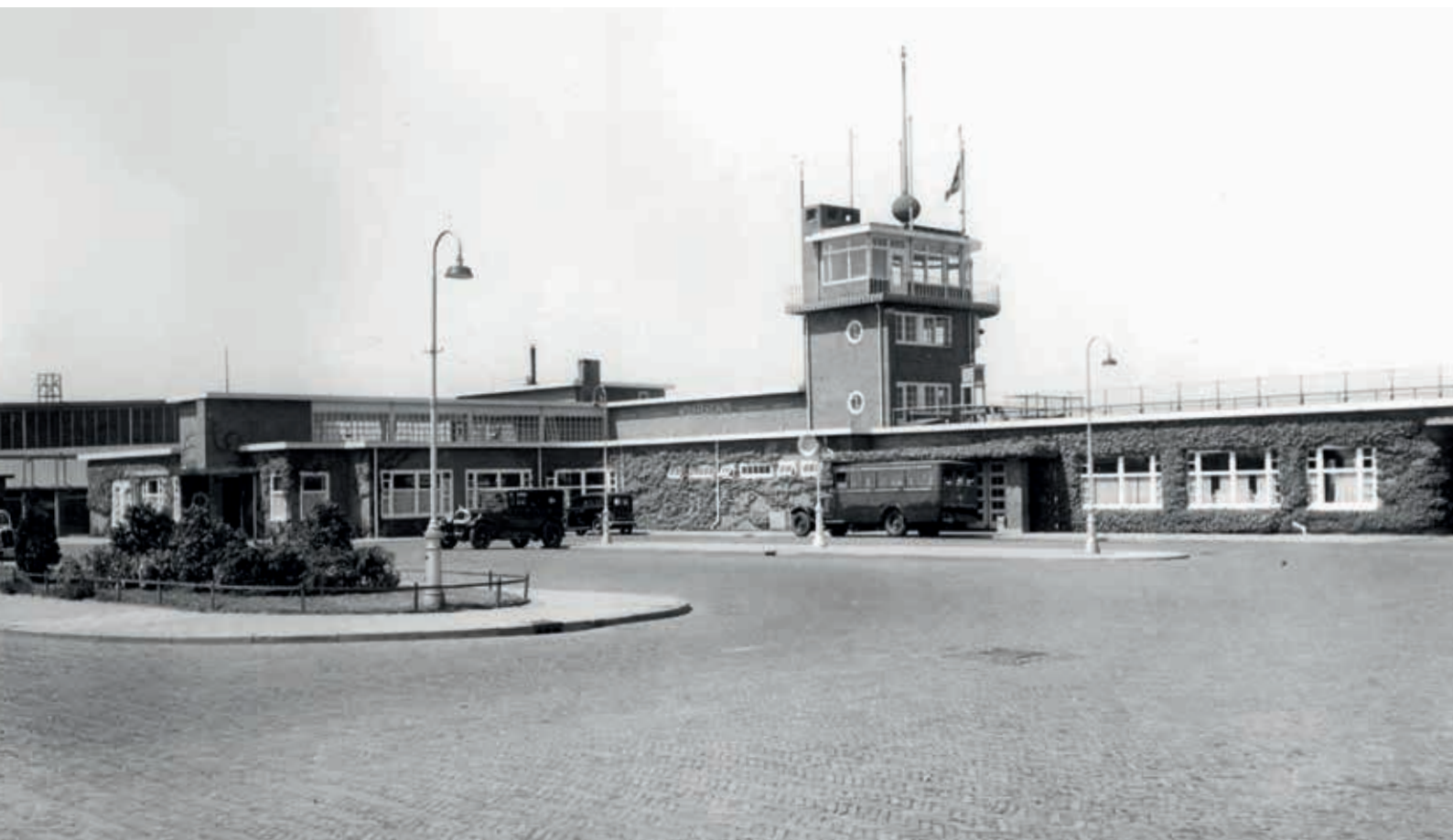
7. Het stationsgebouw vanaf de landzijde gezien, ca. 1929 (SAA, 30470 Archief van Luchthaven Schiphol)
