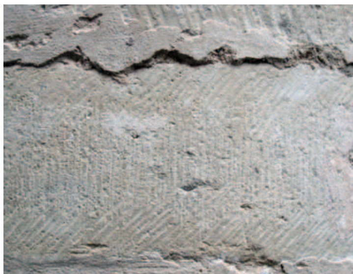
5. Fase IIa van de steenhouwchronologie voor witte kalkzandsteen op de westelijke halfzuil van het oude pastoorskoor. Op het middendeel van het gehouwen steenoppervlak komen verticale, scherp ingesneden parallelle lijnen voor. Deze zijn het resultaat van het gebruik van de steenbijl (zwaaiivlechte) of de polka. De randslag wordt gekenmerkt door ruwe, verder uit elkaar liggende streepjes. Deze zijn aangebracht met de beitel (foto Frans Doperé)
