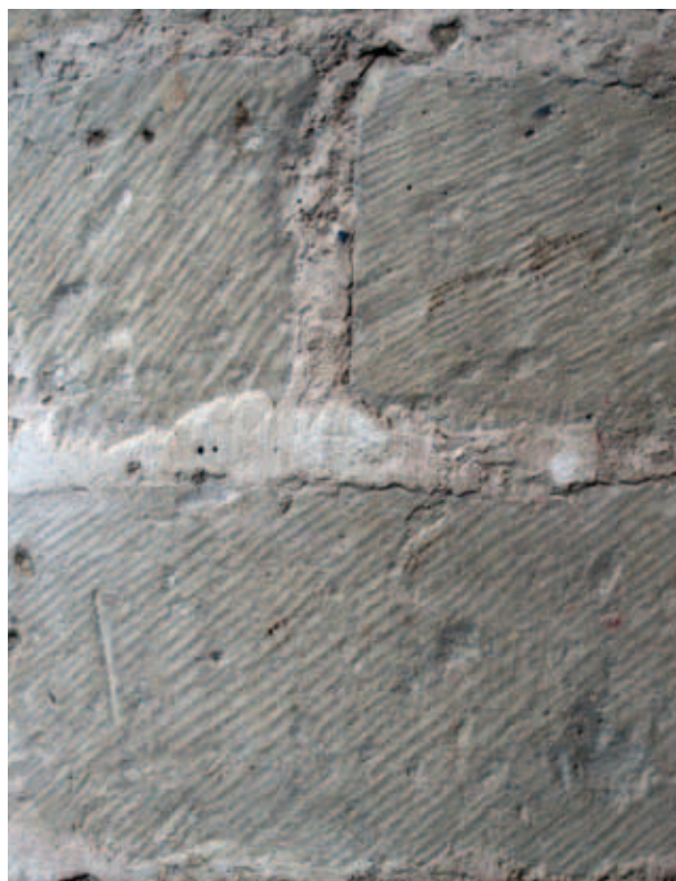
6. Fase IIB van de steenhouwchronologie voor witte kalkzandsteen op de noordwestelijke vieringpijler. Over het gehele oppervlak van de gehouwen steen komen schuine parallelle lijntjes voor, die het resultaat zijn van de bewerking met de beitel. Er is dus geen randslag meer (foto Frans Doperé)
