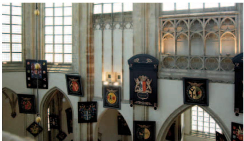
11. Deel van het blindvenster in de koorapsis. Hier wordt een over de volledige hoogte opgaand venster gesuggereerd, dat ter hoogte van het triforium een onderverdeling kent in de vorm van een reeks driepasboogjes (foto Karel Emmens)
