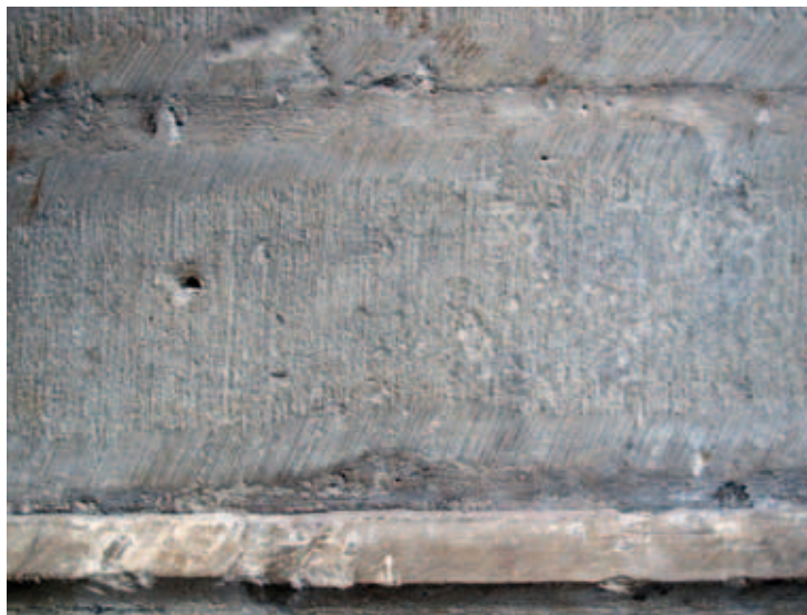
2. Fase I van de steenhouwchronologie voor witte kalkzandsteen op de zuidoostelijke vieringpijler. Op het middendeel van het gehouwen steenoppervlak komen verticale, scherp ingesneden parallelle lijnen voor. Deze zijn het resultaat van het gebruik van de steenbijl (zwaaiivlechte) of de polka. De randslag wordt gekenmerkt door fijne, zeer nauw op elkaar aansluitende streepjes. Deze zijn aangebracht met de beitel (foto Frans Doperé)
