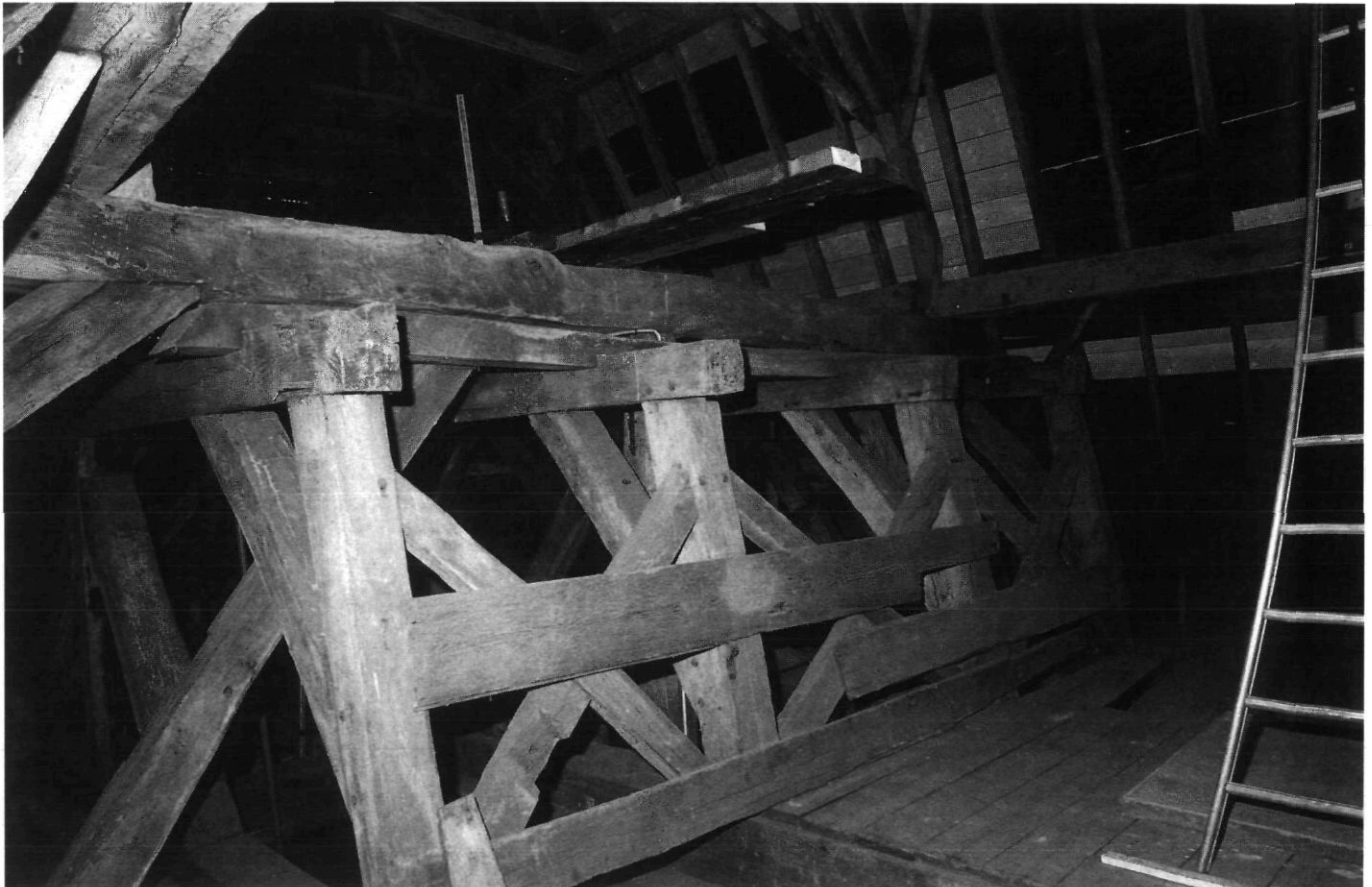
Afb. 2. Overzicht van de klokkenstoel in de kap van de kerk.
