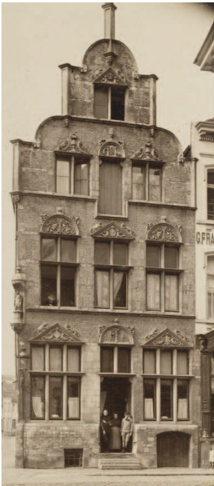
11. Bij de restauratie in 1900-1902 werd de gevel ontleisterd en werden onder meer de reliëfs boven de muuropening op de begane grond gereconstrueerd (Stadsarchief Mechelen)
