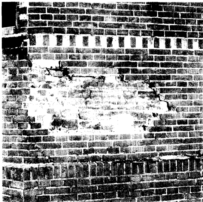
Afb. 4. Gat in de omklamping bij het koor, met achter de hier halfsteens dunne klamp de rond verlopende middeleeuwse sluitingsmuur (foto A. v.d. Wal, 1984 RDMZ)
