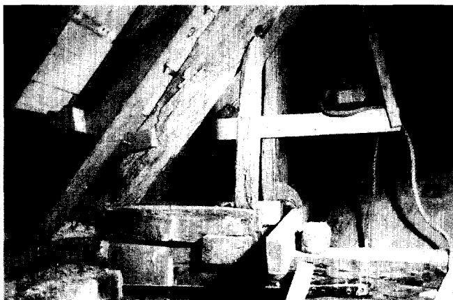
Afb. 25. Dubbele muurplaat met blokkeel en standzonen aan de noordzijde van de kap (foto F. Haans 1998)
