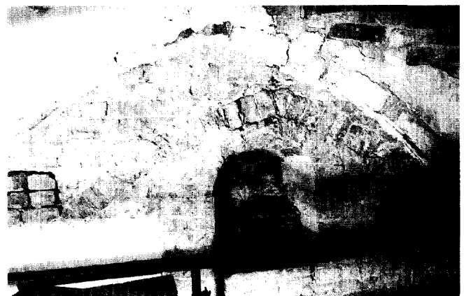
Afb. 15. Het teruggevonden venster met daarboven de afgehakte muraalboog van een eerdere overwelling in de noordwand van de oostelijke schiptravee (foto F. Haans 1998).
