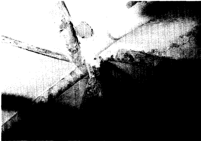
Afb. 22. Het koorgewelf. De samenkomst van ribben in een knoop, waaruit een hangende sluitsteen ontspringt. Foto F. Haans 1998
