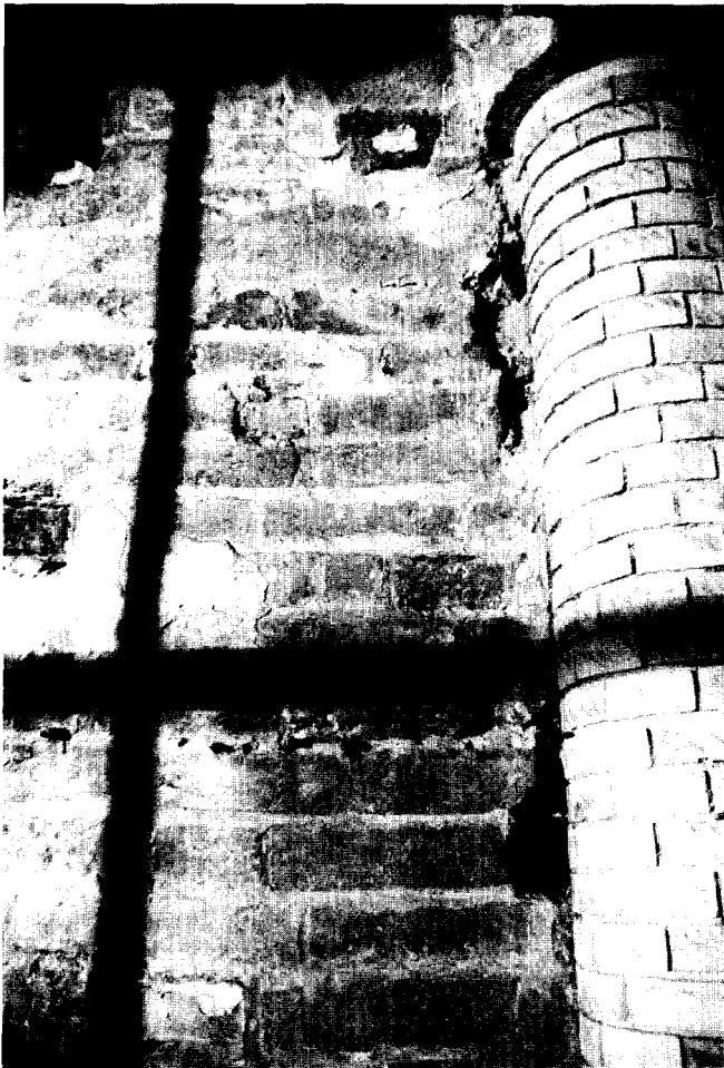
Afb. 17. De gereconstrueerde rondpijler bij de overgang van schip en koortravee aan de noordzijde. Boven de pijler een kraagsteen in rode zandsteen en tufsteen en een deels rond verlopende bakstenen profiellijst. (foto F. Haans 1998)
