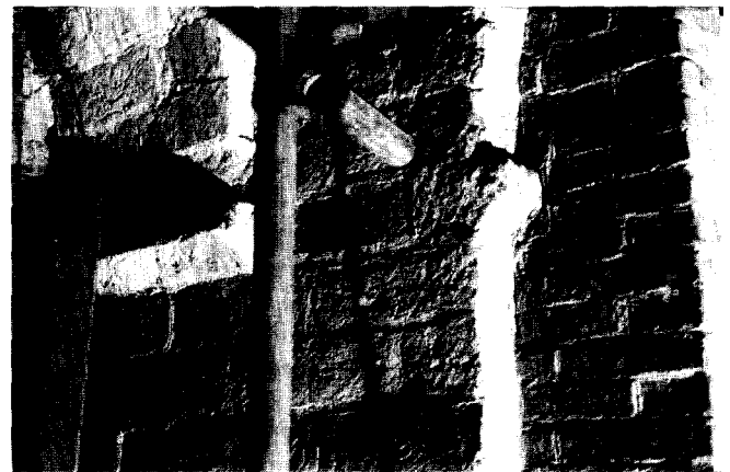
Afb. 9. Interieur van de verdieping van de noordelijke nevenruimte van de westbouw. Links het boogrestant met impost van de gedichte doorgang naar het schip en rechts de hoog en impost van de doorgang in de torenromp. Rechts is nog het metselwerk zichtbaar van de 18de-eeuwse versterking van deze doorgang (foto F. Haans 1998).
