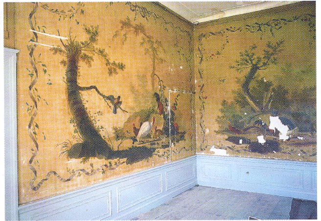
Afb. 4. De Fazantenkamer in 1997, tijdens de restauratie.
