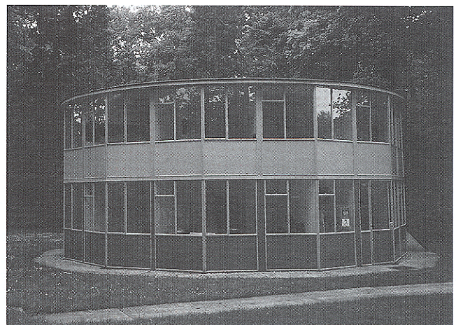
Afb. 6. Dienstbodehuis Zonnestraal na restauratie (foto: M.G. Polman 1999).
