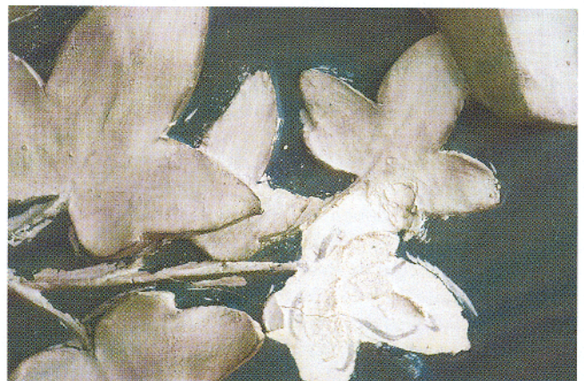
Afb. 6. Zwarte ondertekening positionering bloemblaadje in stucveld westwand
