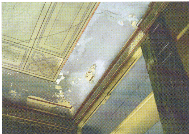
Afb. 11. Oudhollandse kamer links van de schoorsteen (ZO), schoonmaakproefjes op het plafond, koof en kroonlijst.
