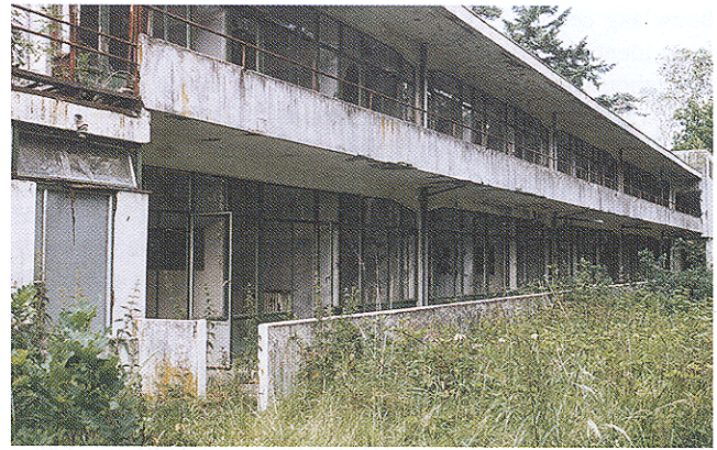
Afb. 5. Sanatorium Zonnestraal Dresselhuyspaviljoen, de originele afwerkklagen zijn nog aanwezig (foto: M.G. Polman 1999).
