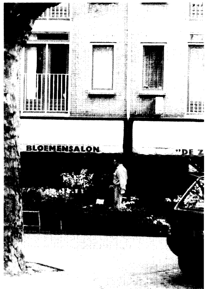
Afb. 9. Huidige stand van zaken van Het Straatje . Foto door Kaldenbach, zomer 1999.
