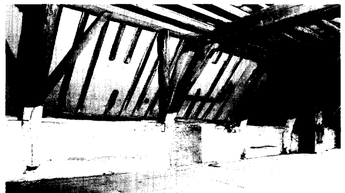
Afb. 14. Zicht op een deel van de zolder met de in het muurwerk ingemetselde spantbenen en de vlieringvloer, beide uit fase III (fotodienst van Het Utrechts Archief 1996).
