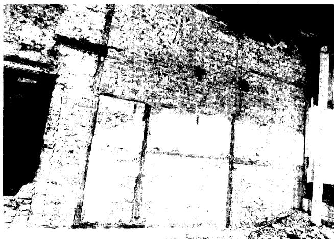
Afb. 13. Vakwerkwand uit fase III als scheidingswand tussen de achterkamer en de gang (fotodienst van Het Utrechts Archief 1996).
