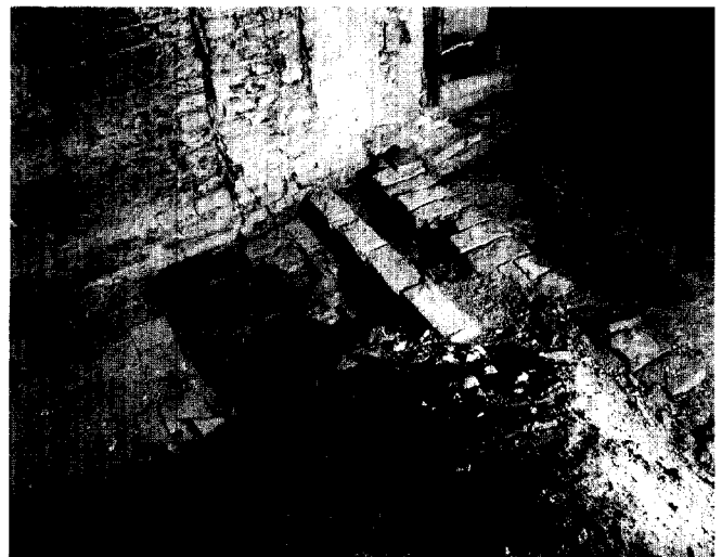
Afb. 12. Overgang tussen voor- en achterhuis met links een halfsteens fundering uit fase II en rechts een steens fundering uit fase III (fotodienst van Het Utrechts Archief 1996).
