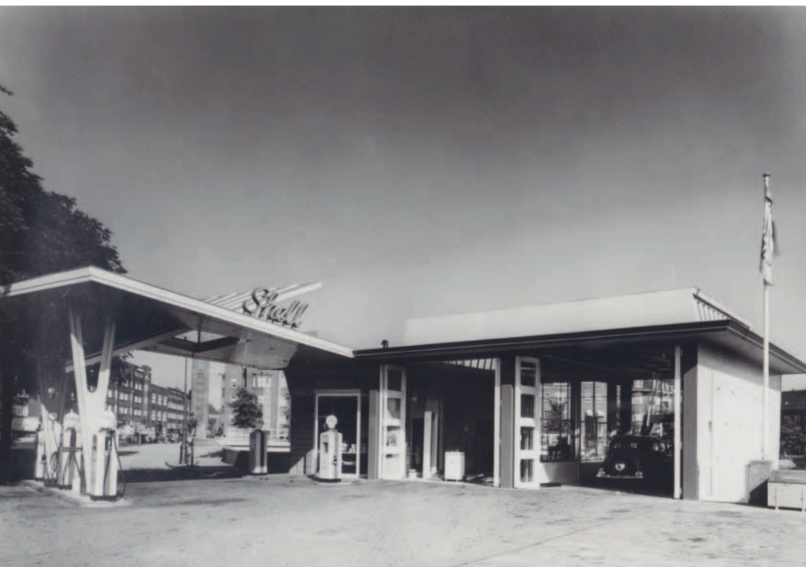
10. Shell-station aan de Hobbemakade in Amsterdam, Arthur Staal, 1954. De luifel is in 1975 vervangen, opnieuw naar een ontwerp van Staal (© Hans Spies / Nederlands Fotomuseum, 1954)
