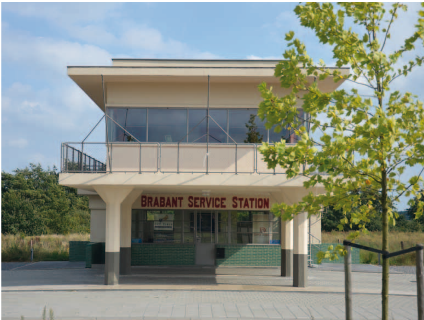
5. Brabant Service Station aan de Vughterweg in Den Bosch, A.V.J.M. Meylink, 1933. Het gebouw is in 2010 in de oorspronkelijke staat teruggebracht (Rinse Tjeerdsma, 2012)
