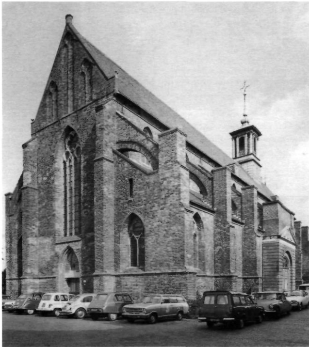
Afb. 7. Broederkerk, voormalige kerk van de dominicanen in Zutphen, (foto: Rijksdienst voor de Monumentenzorg, juni 1974).
