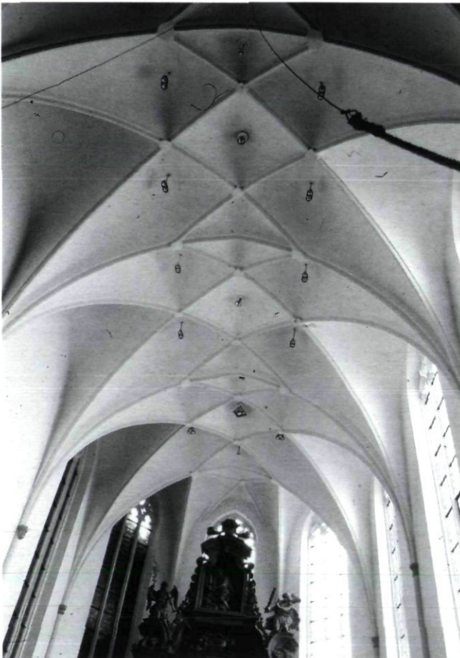
Afb. 18. Minderbroederskerk, voormalige kerk van de franciscanen in Weert, thans R.K. kerk: netgewelf op het koor (foto: THOC, april 2001).
