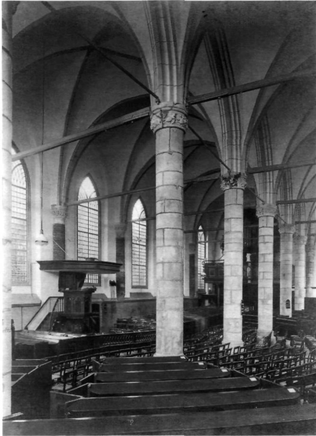
Afb. 22. Broederkerk, voormalige kerk van de franciscanen in Kampen, thans N.H. kerk: zicht op het tweebeukige schip (foto: Rijksdienst voor de Monumentenzorg, november 1923).
