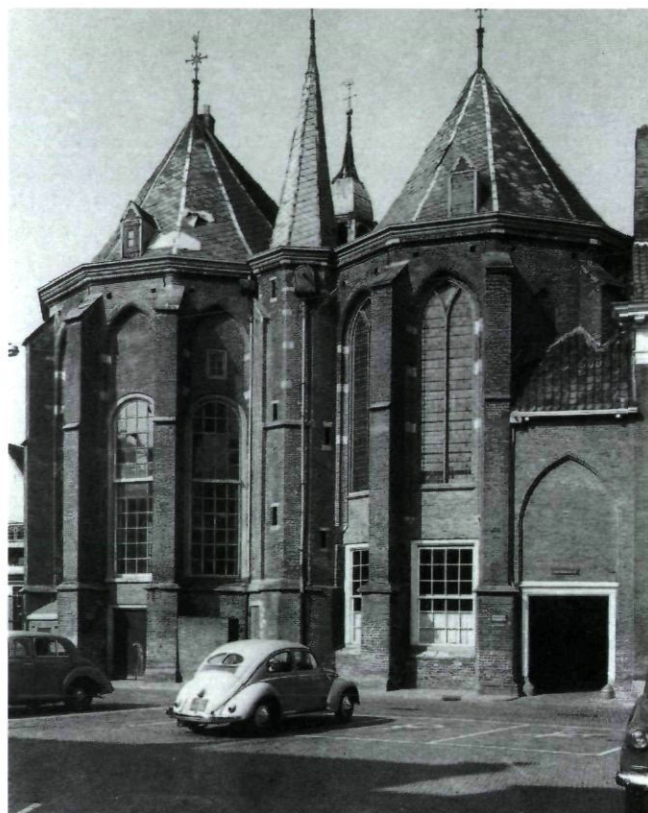
Afb. 5. Broederkerk, voormalige kerk van de franciscanen in Kampen, thans N.H. kerk: zicht op het tweebeukige schip (foto: Rijksdienst voor de Monumentenzorg, november 1923).
