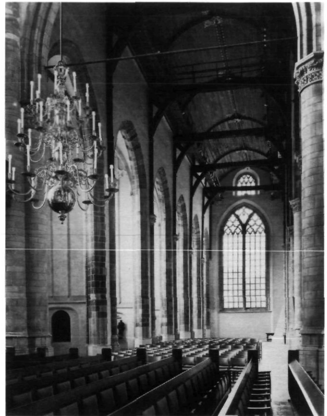
Afb. 6. Zuider zijbeuk (RDMZ 1970). Links in steen overwelfde zijkapellen met bogen van tufsteen. Daarboven doods muurvlak met stijlen. Tongewelf in de kapconstructie.
