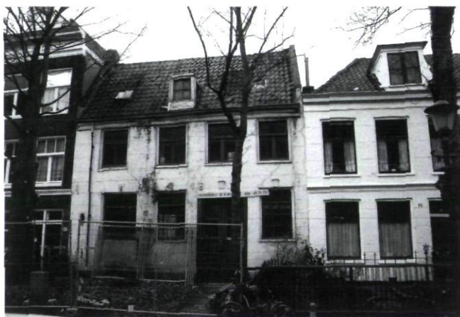
Afb. 12. Bellamystraat 80 Amsterdam (dia auteur 2000).
