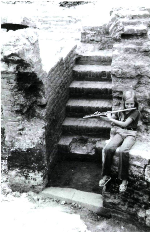
Afb. 3. Utrecht - foto van affiche "Een monument is om op te spelen, niet om óp te blazen". Foto auteur, 1976.
