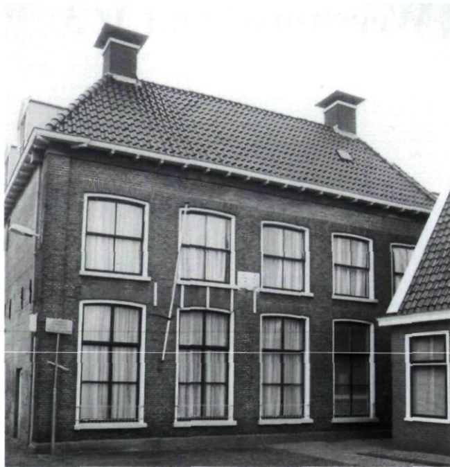
Afb. 1. Voorgevel van het hoofdgebouw. Deze 19de-eeuwse gevel is verhoogd ten behoeve van de vernieuwing van de kap in 1958 (foto J.A. van der Hoeve, 1997).
