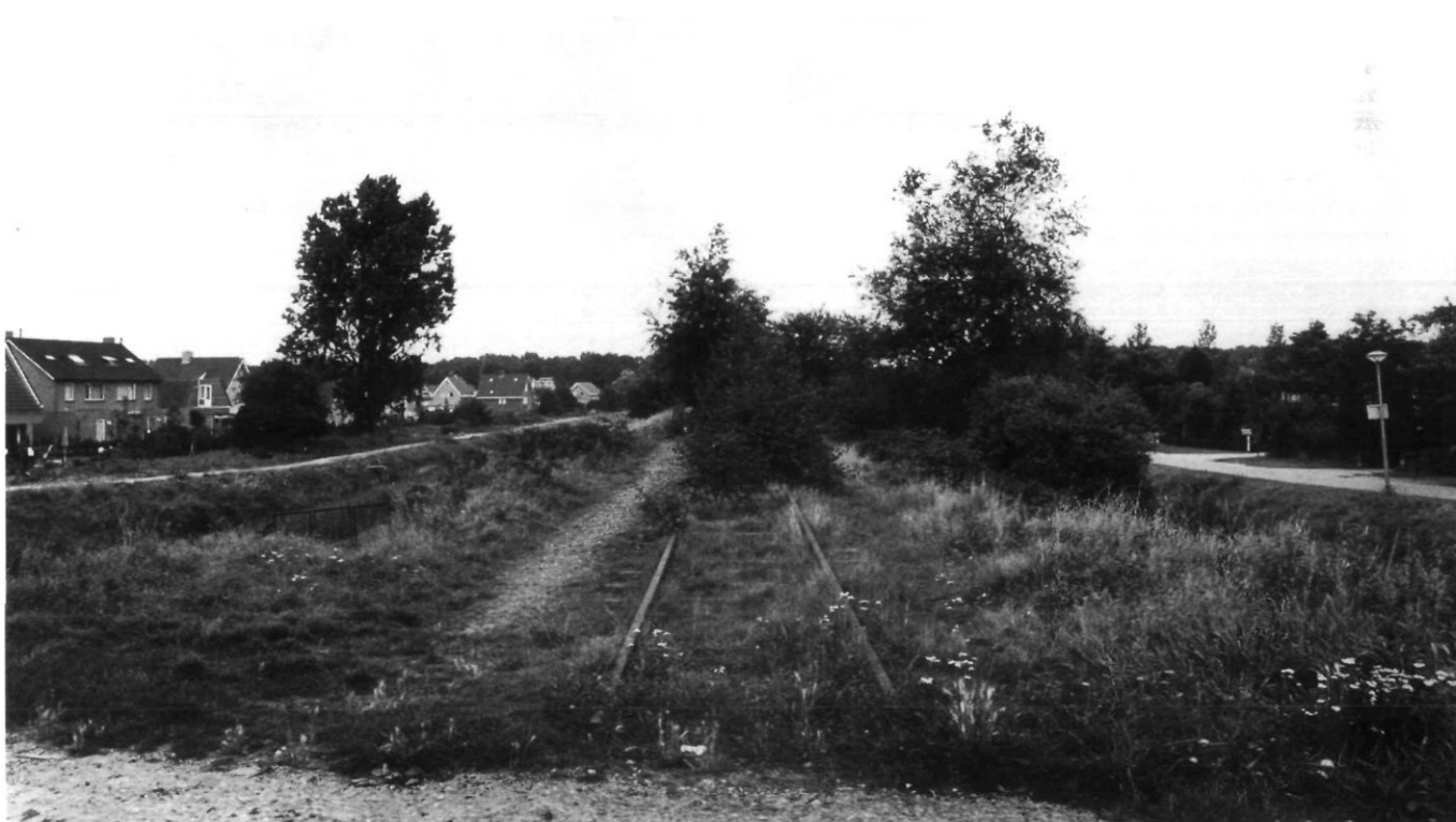
Afb. 1. Waalwijk, voormalige spoorwegovergang in het Halve Zolenlijntje bij de Bloemendaalseweg en de Hoefsteeg. Foto L.Tangel, RDMZ, augustus 1988.
