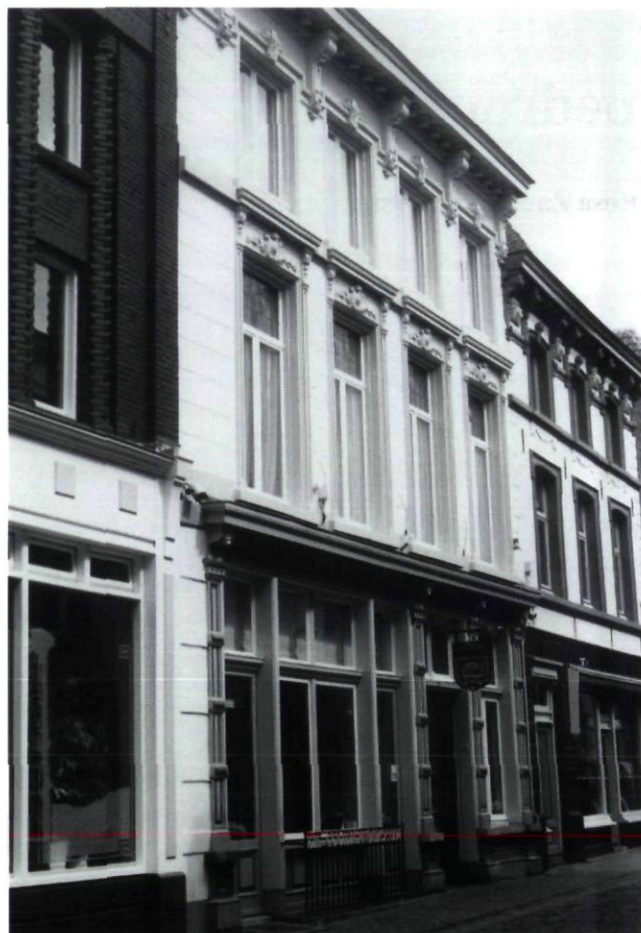
Afb. 11. Voorgevel na restauratie.
