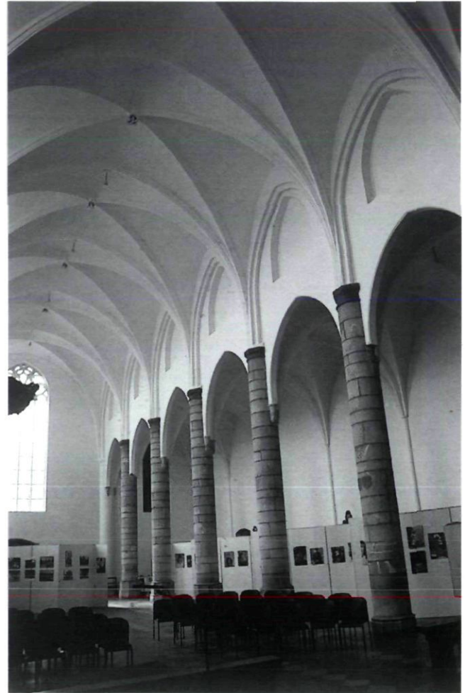
Afb. 12. Weert, schip van de Franciscanenkerk waarvan de kap in 1538 ± 6 jaar (d), die op het koor omstreeks 1514 (d) gebouwd moet zijn, maar die van de westelijke aanbouw met houten tongewelf uit 1469 ± 6 jaar (d) dateert en waarschijnlijk in verband gebracht kan worden met de consecratie in 1462 waarbij pater Jan Brugman aanwezig was (foto auteur 2001)
