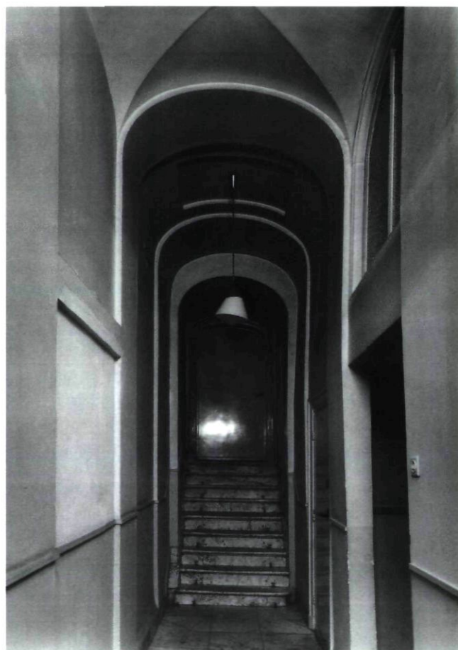
Afb. 16. No. 80. Gang en trap naar de Maaszaal, verlicht door vensters boven lantaarn. (RDMZ 1968).
