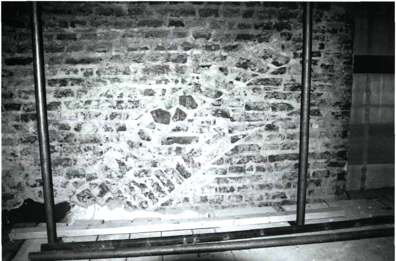
Afb. 10. In de binnenmuur van de meest oostelijke travee in de noordbeuk zijn tijdens de laatste restauratie deze bouwsporen van lage gewelven aan het licht gekomen.
