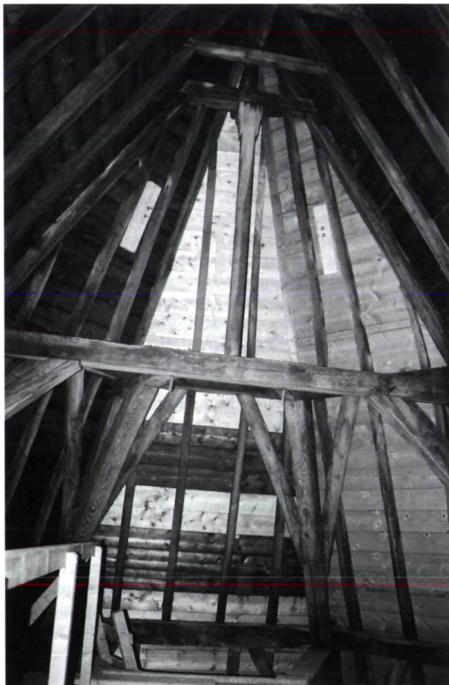
Afb. 12. De kapconstructie in de koorsluiting.
