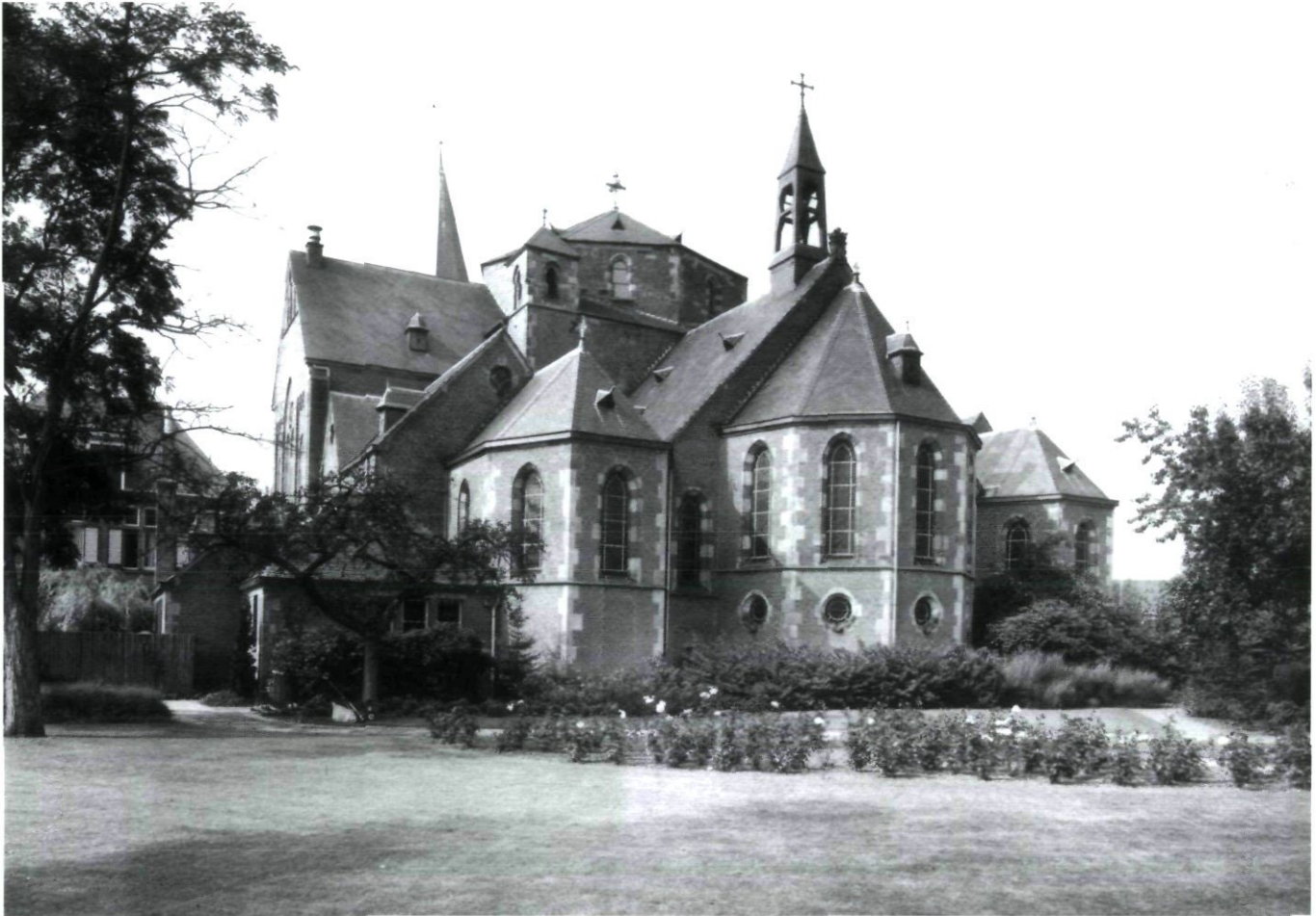
Afb. 7. Exterieur van de oostpartij van de kerk van Denekamp vanuit het oosten, foto A.J. van der Wal 1982, archief RDMZ.
