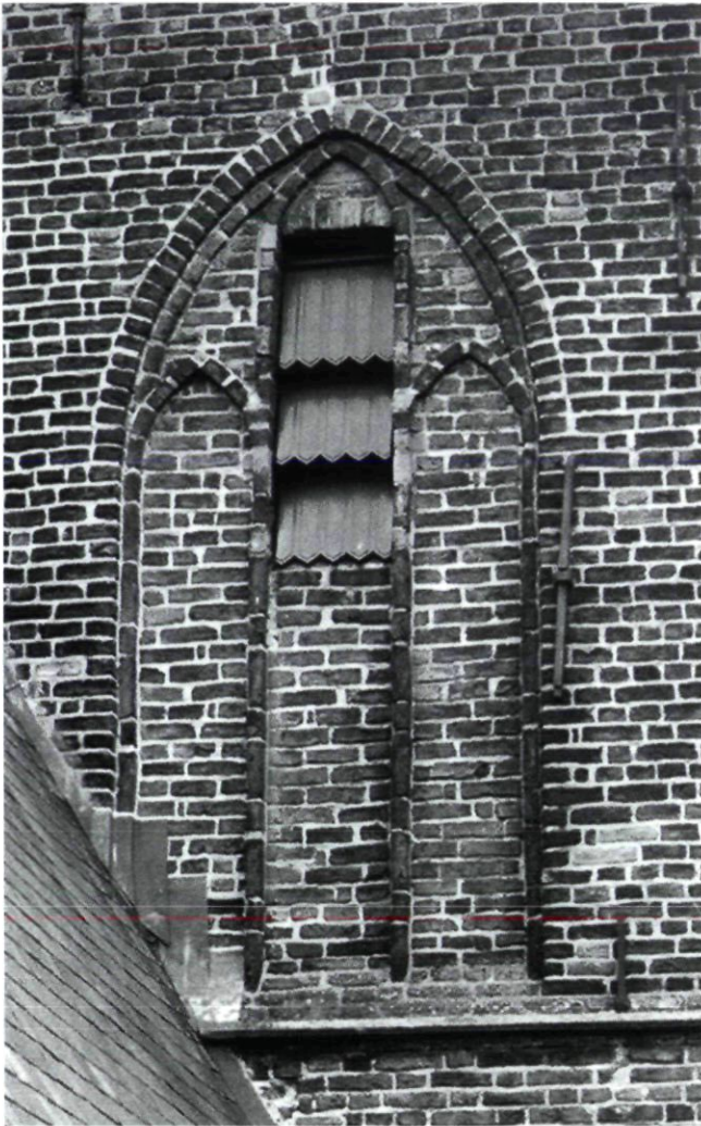
Afb. 6. Detail van de laat-13de-eeuwse onderbouw van de toren. De bakstenen traceringen vertonen overeenkomst met die in de Zutphense Broederenkerk, maar hebben een ongebruikelijke vormgeving met verticaal geplaatste bakstenen in de montants.
