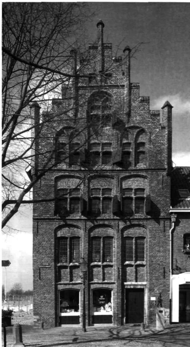
Afb. 14. Venlo, Kwartelenmarkt 1, Romerhuis, laat-middeleeuws diep huis met een topgevel aan de straat. Het pand was in het begin van de 20ste eeuw nog in het bezit van een vakwerk achterhuis, dat bij oorlogsbombardementen zwaar beschadigd raakte. (foto: Gemeente Venlo)
