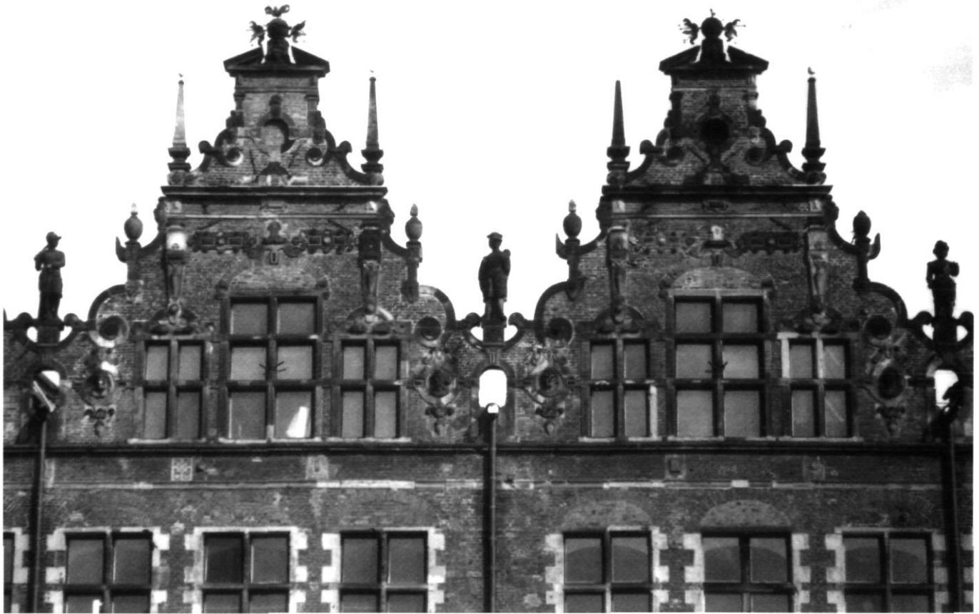
Afb. 5. Detail van twee topgevels van 4.
