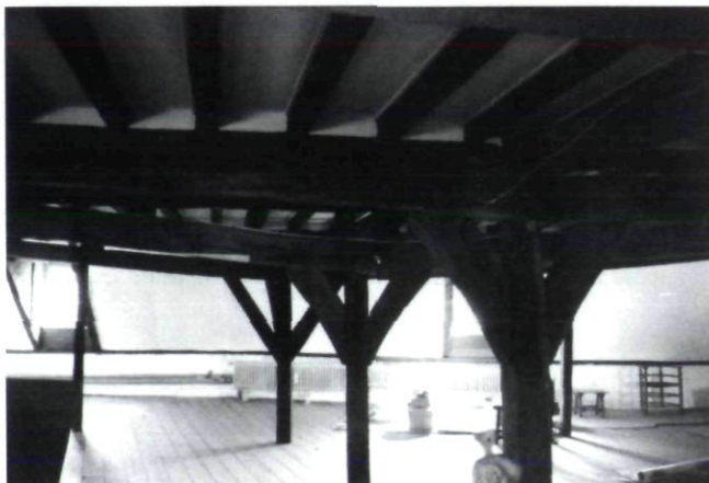
Afb. 12. Grote Looiersstraat 6, constructie met standvinken op zolder, gezien naar het oosten (foto B.Dukers)
