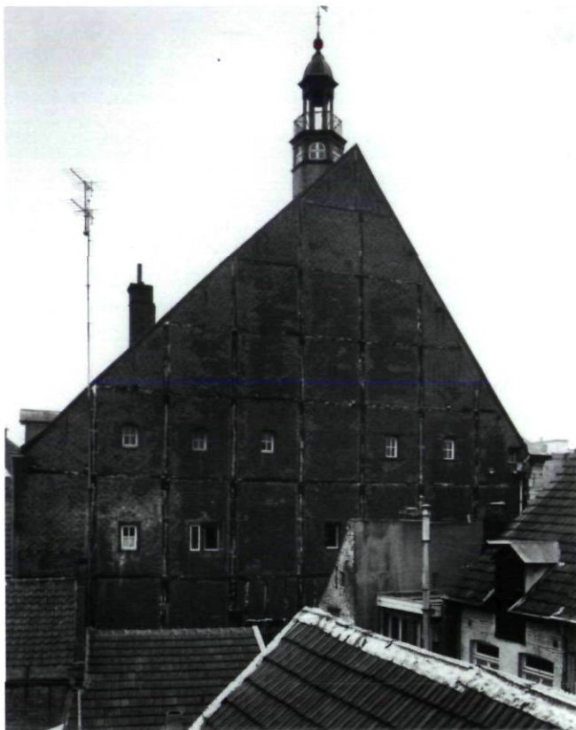
Afb. 1. Noordelijke zijgevel van het Dinghuis, aan de Jodenstraat. (foto: RDMZ 1961)
