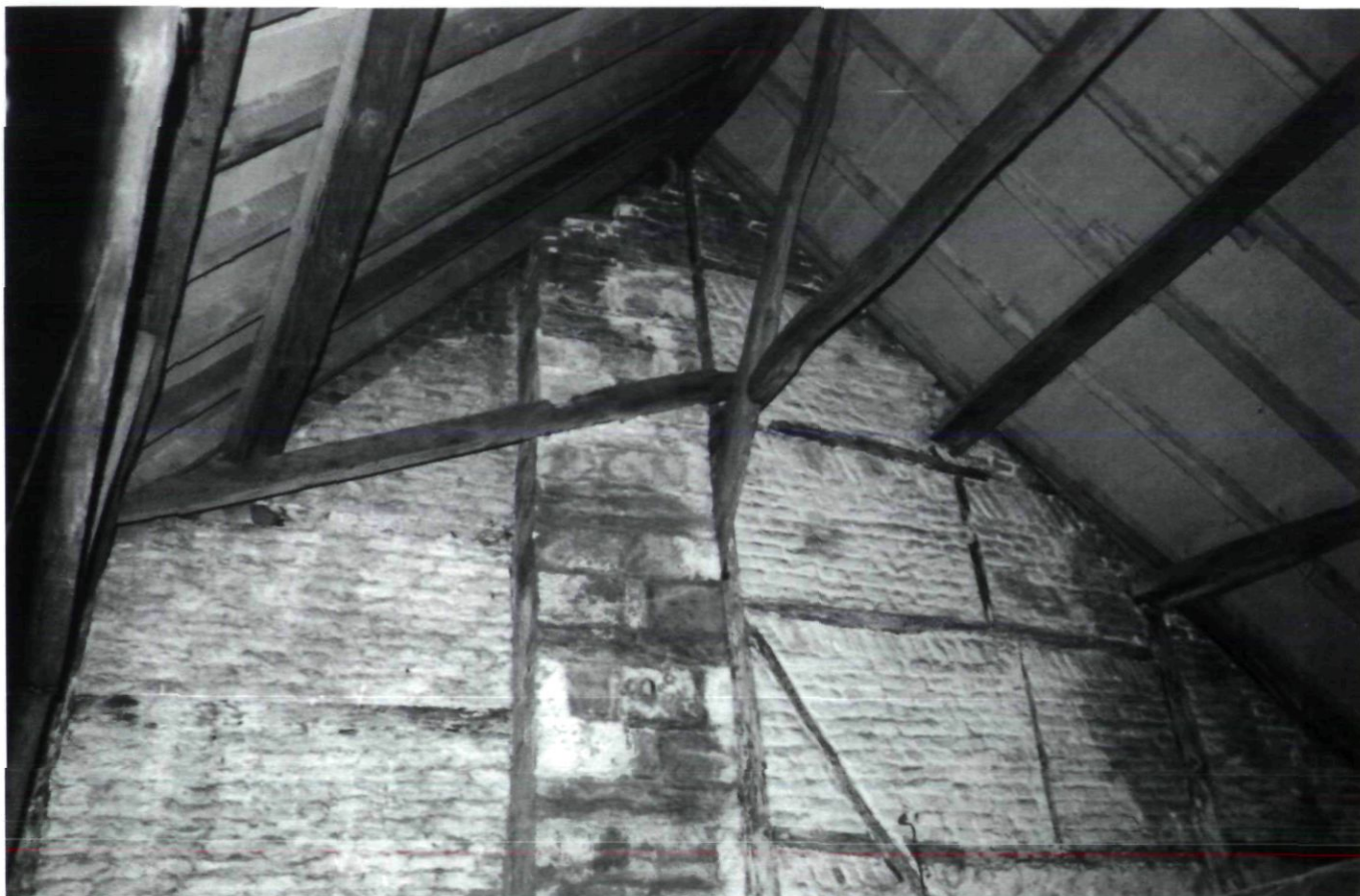
Afb. 3. Vakwerk tussenmuur Kleine Staat 9-11, gezien vanaf het zuiden. (foto B.Dukers)
