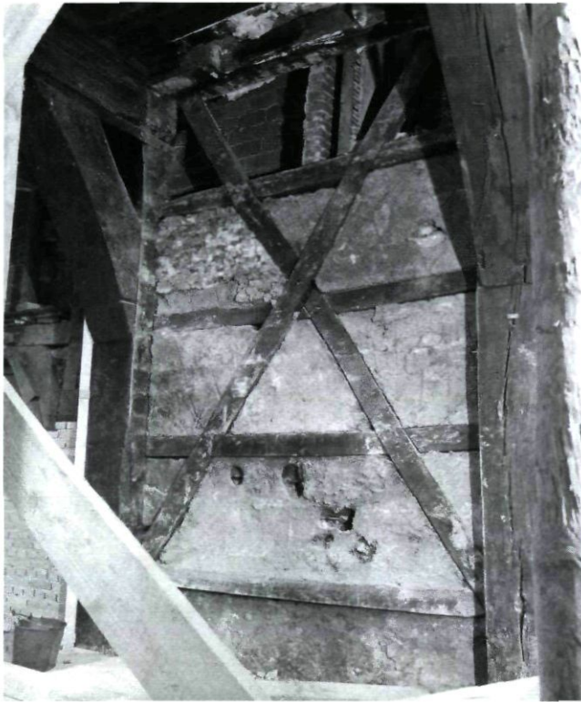
Afb. 2. Vakvulling met Andreaskruis in tussenwand Dinghuis en Kleine Staat 3, gezien vanaf Dinghuis. Vrij gelegd tijdens restauratie (foto RDMZ)
