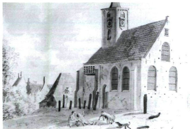
Afb. 12. H. Tavenier: De Hervormde kerk vanuit het zuidoosten, 1790.
