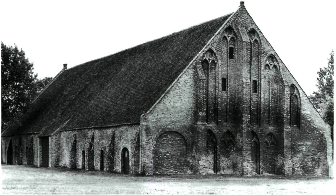
Afb. 1. Zicht op het exterieur van de schuur Ter Doest, gezien vanuit het noorden (foto D. Nuytten, 2001)
