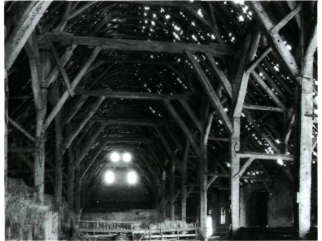
Afb. 3. Zicht op het interieur en de kap van Ter Doest (foto D. Nuytten, 1988)
