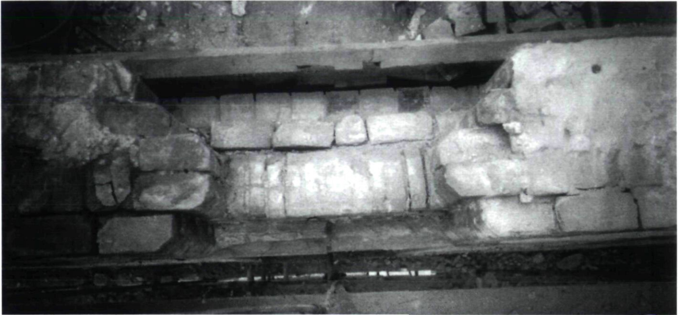
Afb. 5. Utrecht, het Duitse Huis. Bovenaanzicht (doorsnede) van het vroegere spitsboogvenster in de oostgevel (foto B.J.M. Klück)
