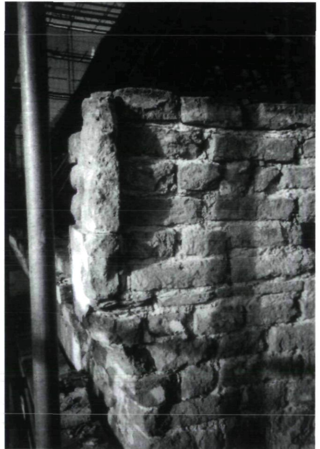
Afb. 7. A. aanzet van de linker schouder van de oostgevel (foto B.J.M. Klück)
