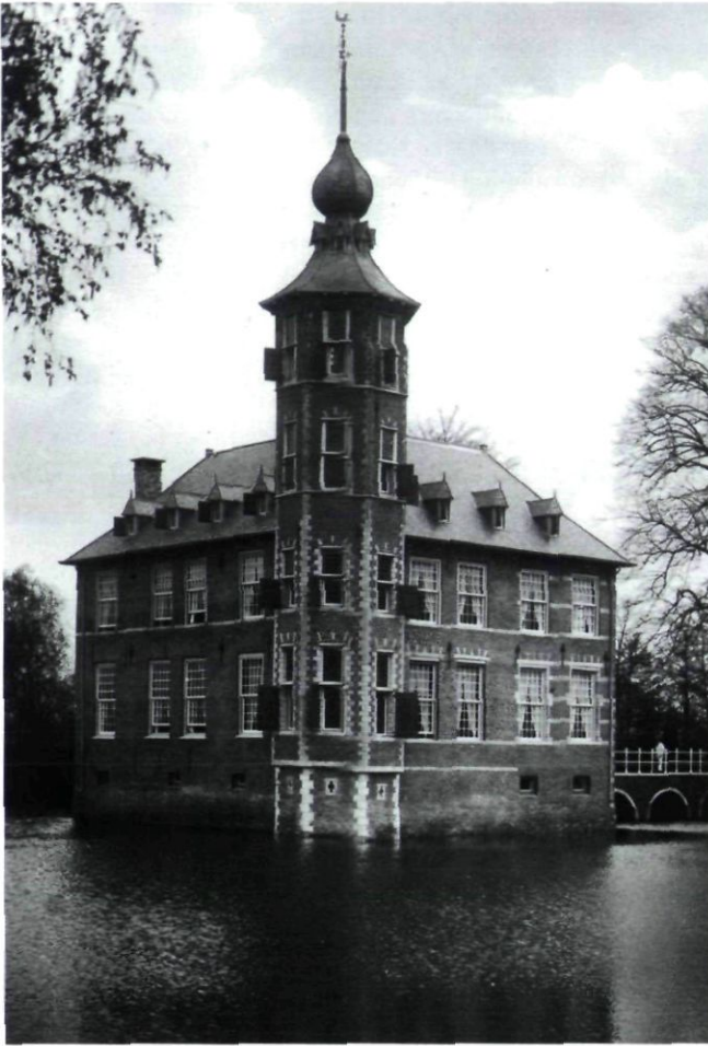
Afb. 9. Kasteel Bouvigne bij Breda. In 1611 in laatste fase afgerond door de eerste raad van Philips Willem, Prins van Oranje. Pronkdak met hoektoren en oorspronkelijk nog een tweede toren op ingang (ansichtkaart)
