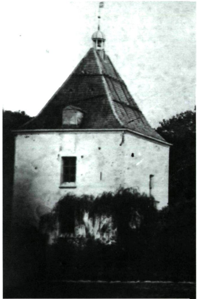
Afb. 2. De oudst bekende foto van het kasteel uit 1880. Zicht op de noordgevel. Rechts naast het venster op de verdieping een lichtspleet, die zich bevindt in de dichtzetting van een ouder venster (repro Ton Verlaaat)
