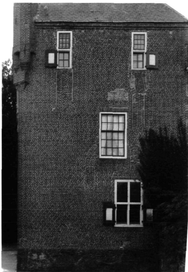
Afb. 9. De noordgevel van de woontoren
