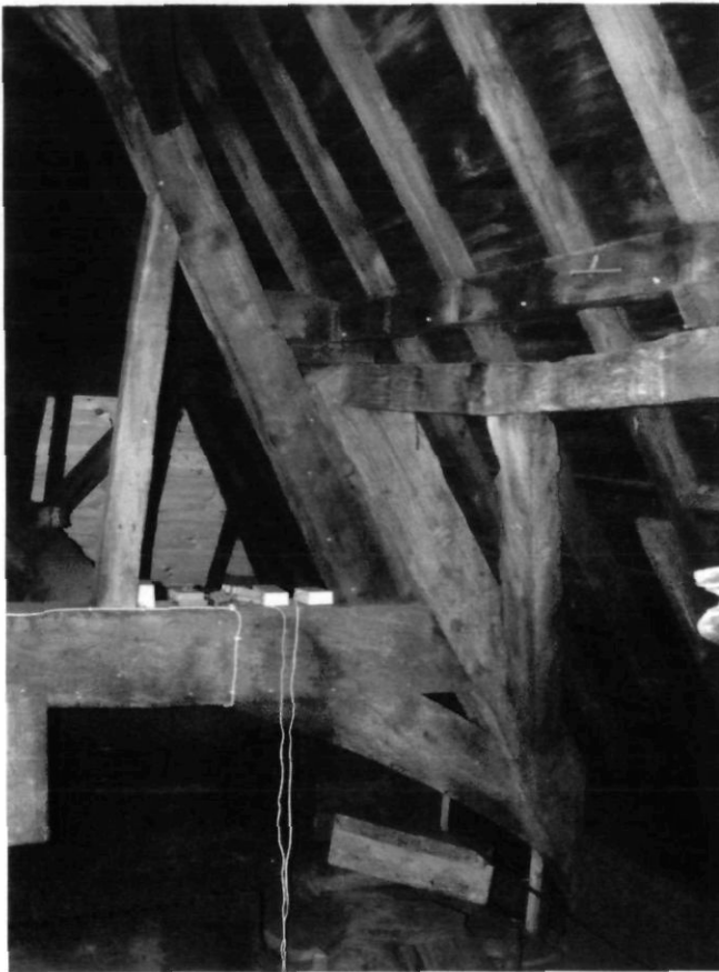
Afb. 6. Detail van de kapconstructie van de woontoren met het zogenaamde Nijmeegse spant in eiken en daarop een 19de-eeuwse constructie in grenen
