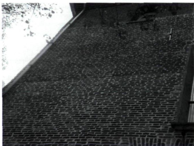
Afb. 7. De ophoging van de toren in de 15de eeuw tekent zich in het metselwerk af door een iets afwijkende kleur (foto D.B.M. Hermans 2003)
