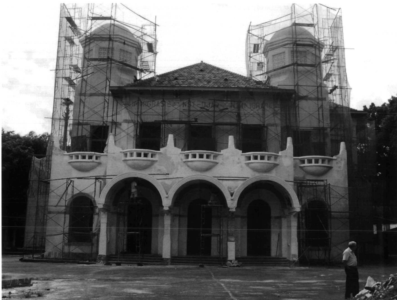
Afb. 4. Voorgevel van het Kunstkringgebouw (foto Arya Abieta, opname januari 2005)
