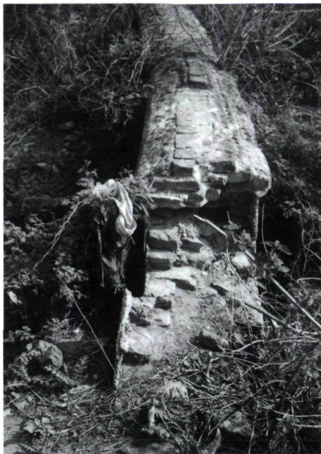
Afb. 6. Het korte muurfragment met bewaard gebleven kap (foto Hans Schiebroek)
