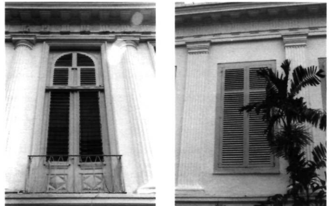
Afb. 7 en 8. De vensters aan de voorzijde van het hoofdgebouw op de piano nobile: een verdiepinghoge kozijn geflankeerd door halfzuilen op het risaliet (links) en een rechthoekig venster geflankeerd door pilasters ter zijde van het risaliet (rechts) (Opname M.J. van Reenen, november 2004)
