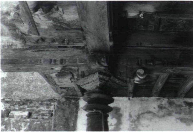
Afb. 17. Houten kolom die de veranda draagt. De detaillering verraaft het vakmanschap van de Indier en de rijkdom van de Hollander (foto Hans Schiebreek)
