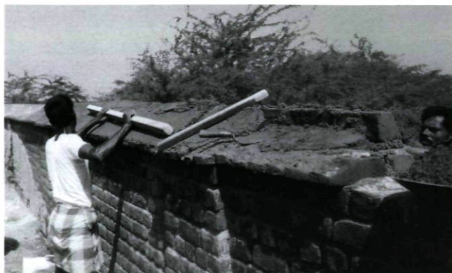
Afb. 7. De muur in uitvoering (foto Hans Schiebroek)
