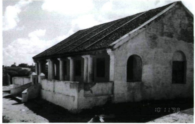
Afb. 15. De oude pastorie, een 18de-eeuws VOC-gebouw (foto Hans Schiebroek)
