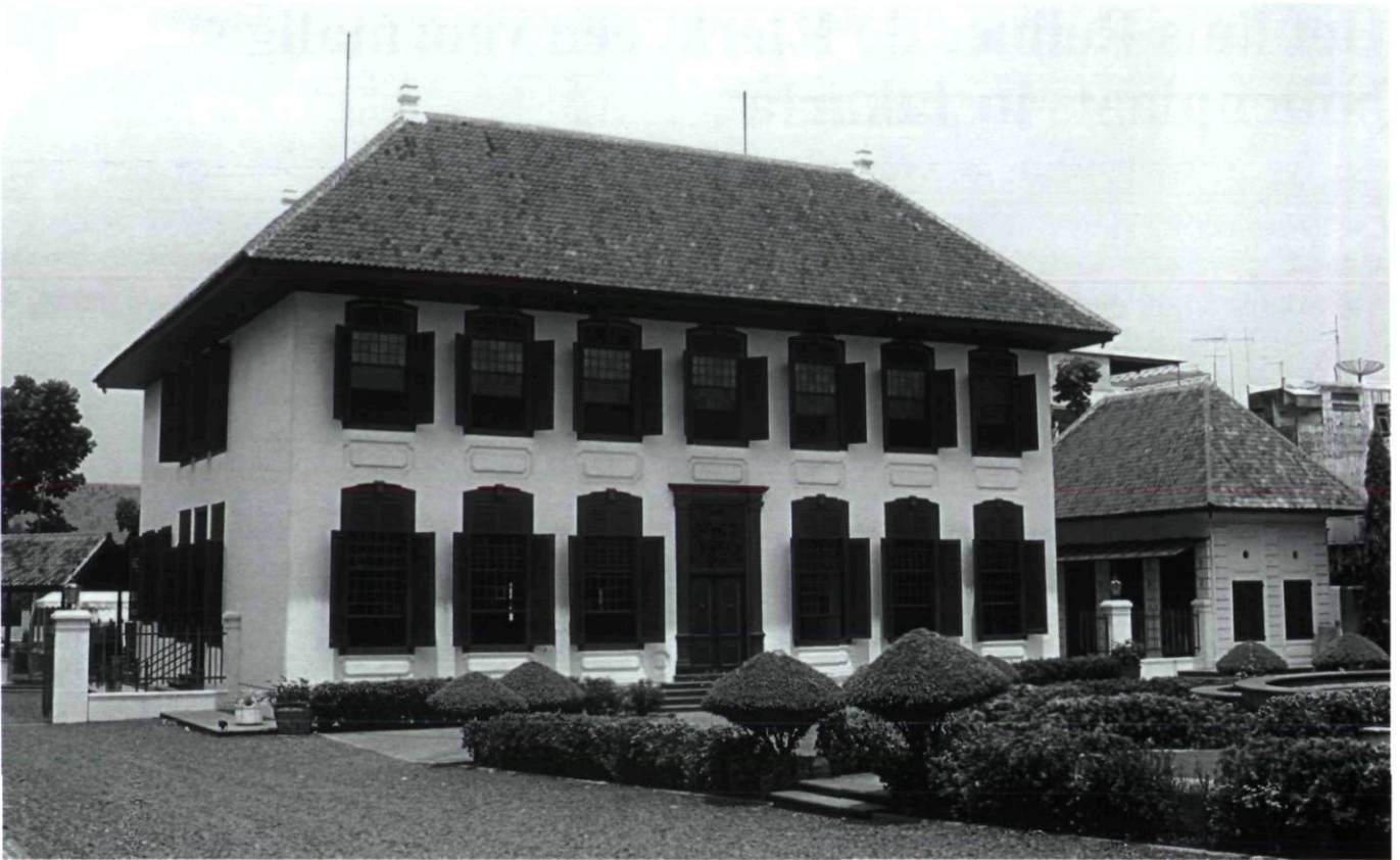
Afb. 2. De voorgevel van het huis Reinier de Klerk na restauratie (foto Cor Passchier)
