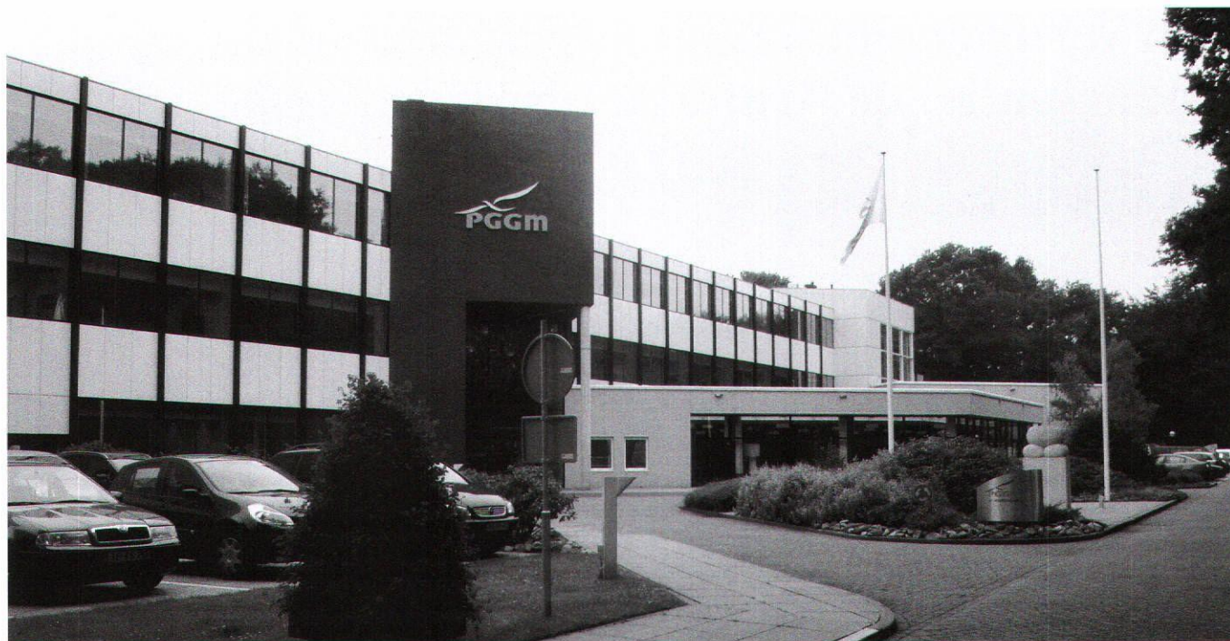
Afb. 2 Noordgevel PGGM, nieuwe ingang en personeelsrestaurant op de plek van de voormalige kapel (foto auteur)
