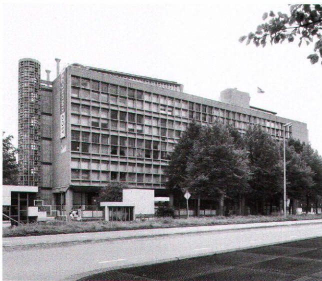
Afb. 3. Amsterdam, lange gevel van de voormalige technische school Patrimonium, ontworpen door B. Ingwersen en C. de Geus als een staalkaart van beton-afwerkingen in 1956.
