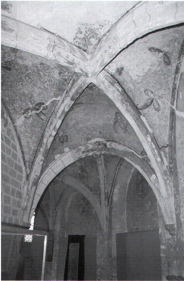
Afb. 10. Bij de herbouw van de kapel aan het einde van de veertiende eeuw werden nieuwe vormen toegepast. In de omgang werden aan de zuid- en oostzijde van de omgang op de begane grond kruisribgewelven aangebracht, die gedeeltelijk op geometrische, gedeeltelijk op figuurlijke consoles rusten.
