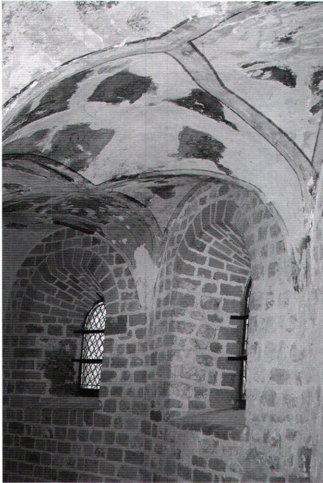
Afb. 5. De kruisgraatgewelven uit de eerste helft van de elfde eeuw zijn voor een deel in het noordelijke deel van de omgang aanwezig. Samen met latere kruisribgewelven zijn ze waarschijnlijk in 1546 van een gekleurde afwerking voorzien.
