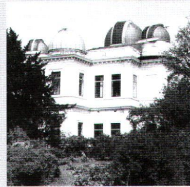
Sterrewacht, Leiden in samenwerking met Veldman + Rietbroek architecten
