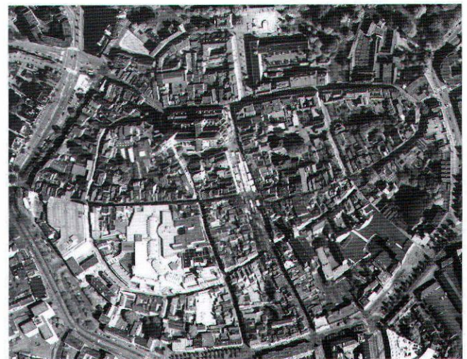
Afb. 3. Tekening en luchtfoto van de historische binnenstad van Breda met herkenbaar de bouwblokken en de grootschalige bebouwing, zoals de parkeergarage aan de Tolburgstraat, de Barones en de Nieuwe Veste (bibliotheek), (tekening Cartografisch Bureau Map, Bert Stamkot)
