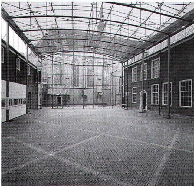
Afb. 6 De glazen Octatube kap van Mick Eekhout over de kloosterhof van het Prinsenhof te Delft. Gezicht op de noordgevel van de Waalse Kerk, verticale afwerking van de kap, zodat het schip vrij blijft (foto RACM)
