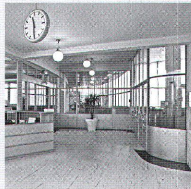
Kantoor Van Nelle, Rotterdam
