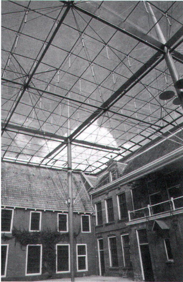
Afb. 17 De Octatube kap met verlengde masten en tui-kabels over de binnenplaats van het Natuurmuseum Fryslân te Leeuwarden (uit: Monumenten 28, 2007)
