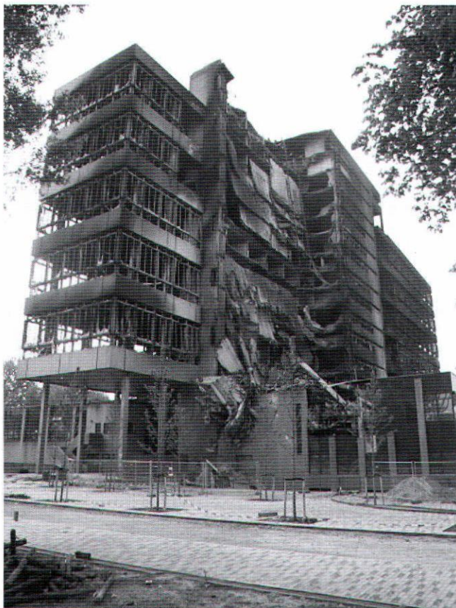
De noordwestelijke zijde van de Faculteit Bouwkunde, TU Delft na de brand van 13.5.2008 (foto Bouw- en Woningtoezicht gemeente Delft)
