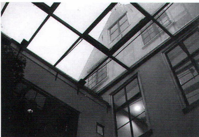
Afb. 12 Gezicht op de nieuwe verhoogde transparante kap over 'de lighthof' van pand Rapenburg 31 bij regenweer (foto auteur)
