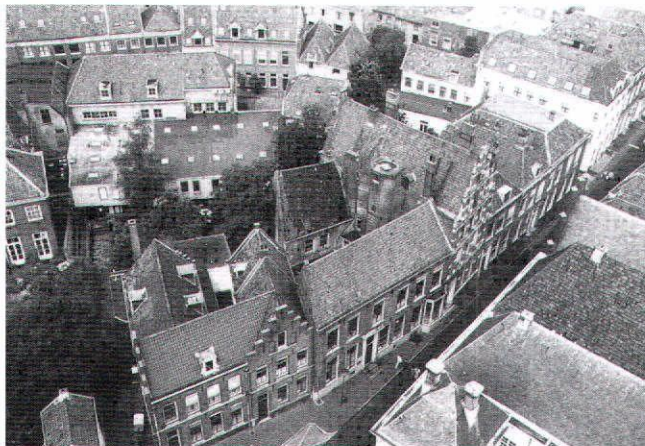
Afb. 8 Plangebied vóór de sloop voor de bouw van het Nieuwe Stadhuis te Zutphen. Op de voorgrond de Lange Hofstraat en verticaal daarop de 's-Gravinnenhofstraat die dood loopt op het Postkantoor (uit: J. Bruseker, Het nieuwe stadhuis van Zutphen, Zutphen 1999 , 10)
